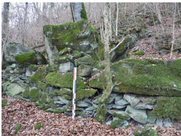
Fig. 120 : Portion du mur d'enceinte
