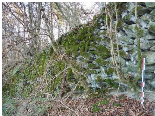
Fig. 123 : Mur de terrassement
