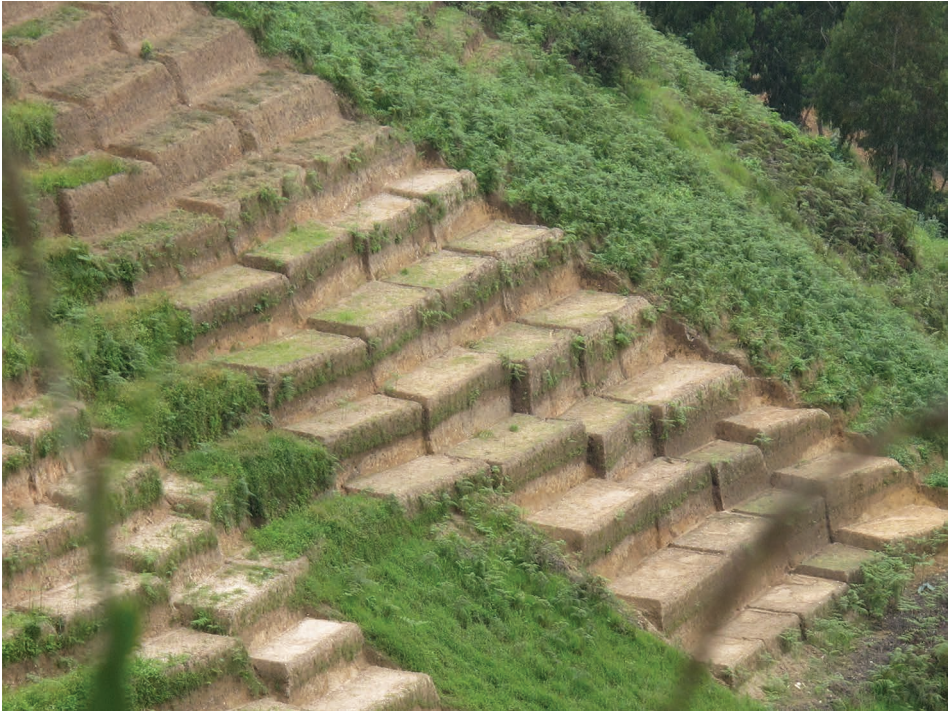
Photo 6.4. Le mythe techniciste de la terrasse radicale, région des monts Uluguru, Tanzanie, (Cochet, 2016). Érosion accrue et abandon, comme le démontre ce versant aménagé en contrebas de la paroisse de Tchenzema.
