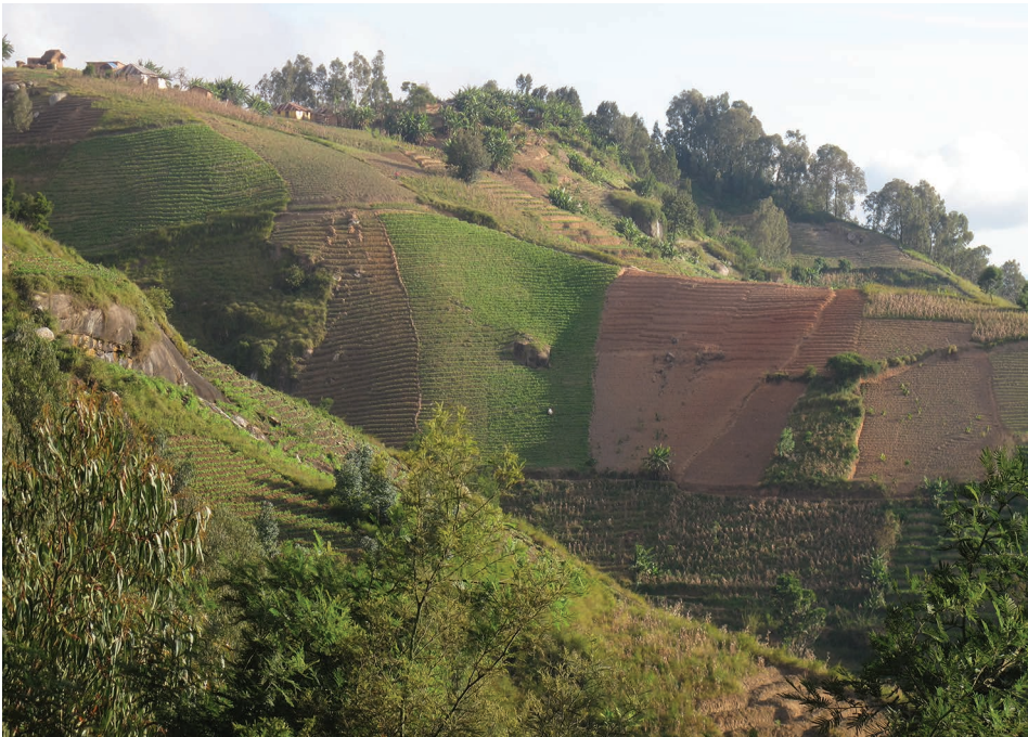
Photo 6.1. Versants aménagés en marches d'escalier en contrebas du village de Nyandira, région des monts Uluguru, Tanzanie (Cochet, 2016).
