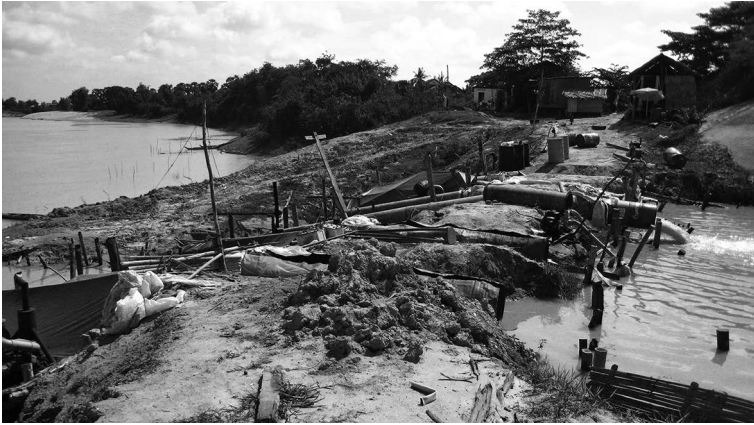
Figure 4.11. Jeu de pompes pour l'irrigation d'un périmètre irrigué collectif à partir du Stung Sen (Ducourtieux, 2014).
