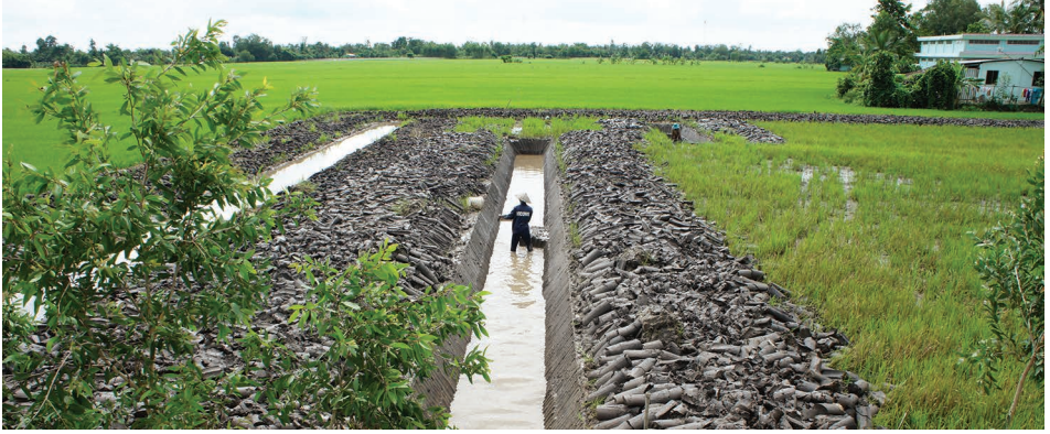
Photo 4.4. Terrassement manuel pour le drainage de verger (conversion de rizière) à Thin Trí, delta du Mékong, Vietnam (Champeaux, 2016).
