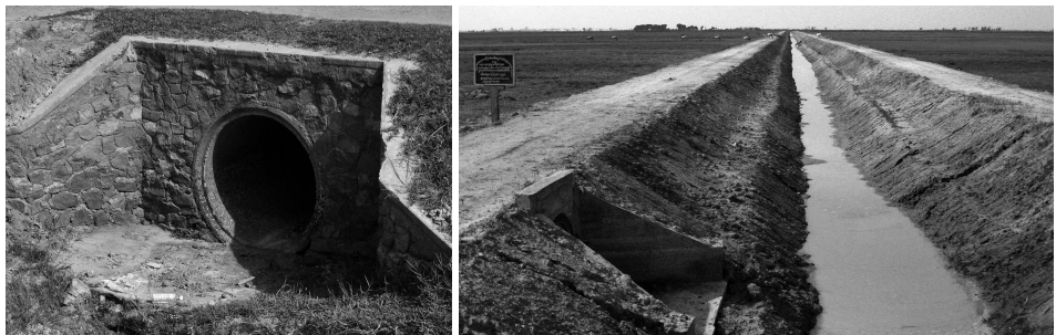
Figure 4.10. Canaux de périmètre irrigué collectif (Ducourtieux, 2014).
