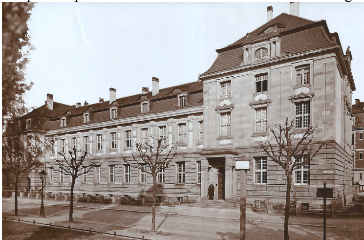
Figure 1 : le bâtiment de l'institut pharmaceutique de Strasbourg, future école supérieure de pharmacie en 1919 érigée en faculté en 1920. Collection P. Labrude.
