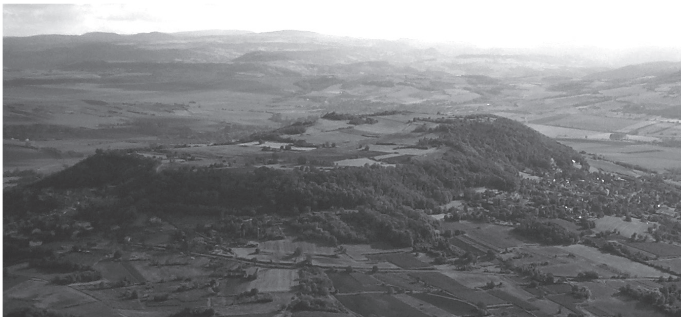
Fig. 1. Photo aérienne du Puy de Corent prise depuis le nord-est.
