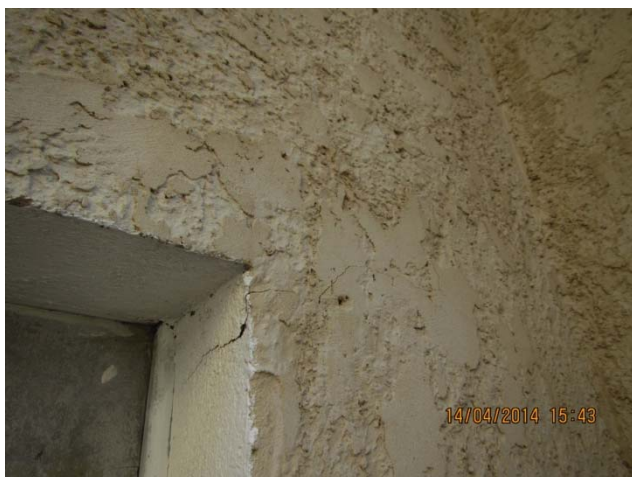
Photo SP02 - Fissures fines dans les murs extérieurs de vulnérabilité A – « Le Village ».
