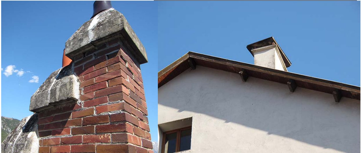
Photo B2 et B3 - Exemples d'effet de torsion sur cheminée : Photo de gauche : Torsion sur la partie haute en brique avec glissement centimétrique, ville mexicaine sous préfecture. Photo de droite : torsion du chapeau en équilibre sur le haut de la cheminée.
