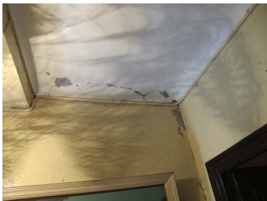
Photo SP1 - SP2 - Dommages de degré 1 – Les Gleizolles
