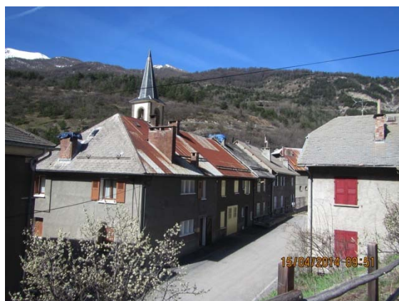
Photo C1 - cheminées tombées et sécurisées (centre du village)
