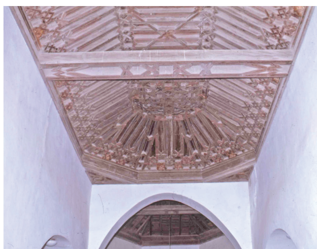
Fig. 13 : Charpente de l'église de Cabañas de la Sagra (Tolède)
