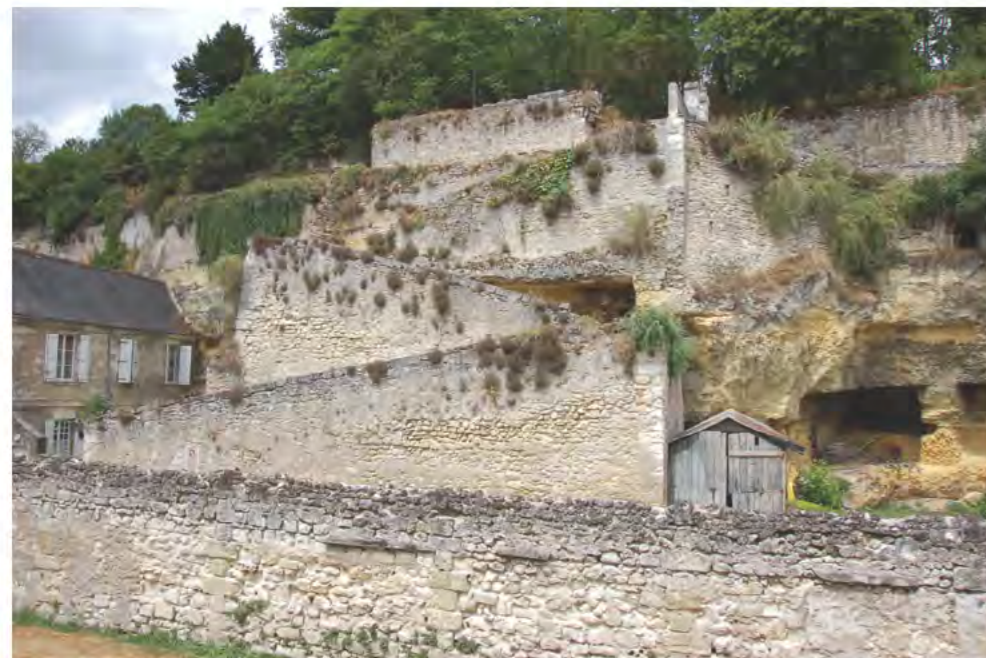
e. Vue générale depuis le sud-est des rampes occidentales menant de la plaine au sommet du coteau
