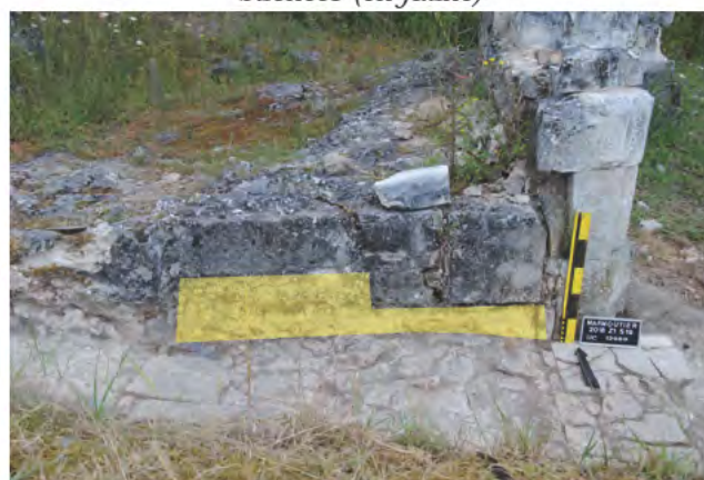
Vue de détail montrant les parties bûchées (en jaune)
