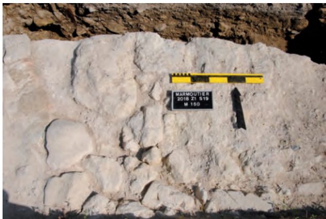
Le mur M 150 vu depuis le sud
