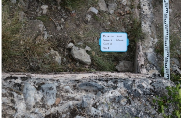
FIGURE 47 – SECTEUR 4 - BÉTON CUVEE X - VERS EEST
