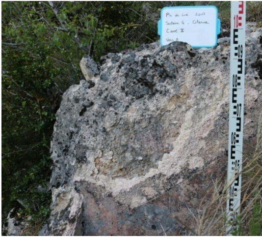
FIGURE 46 – SECTEUR 4 - BÉTON CUVEE X – VERS OUEST
