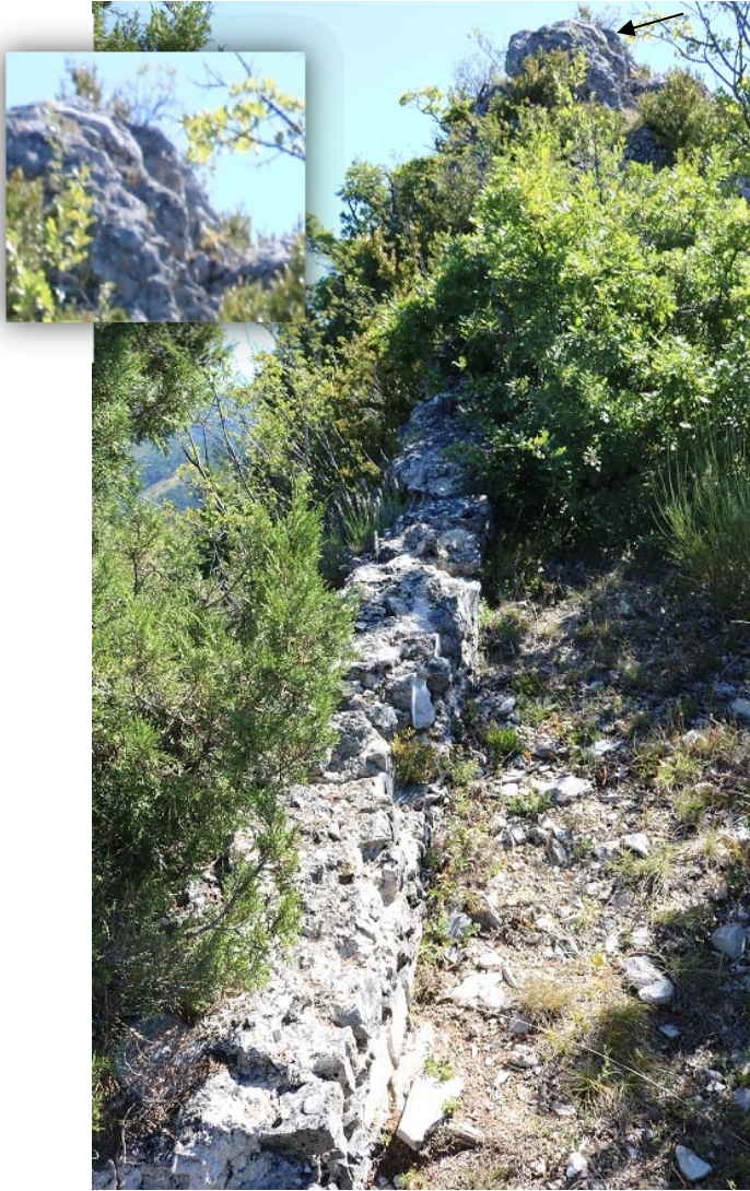
FIGURE 70 – SECTEUR 5 - MUR QUI LONGE LA CRÊTE – VERS EST (AVEC DÉTAIL DU CREUSEMENT 2)
