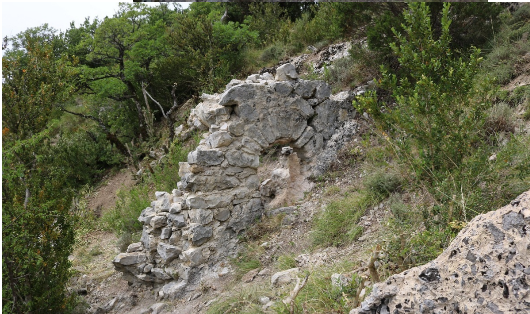
FIGURE 36 – SECTEUR 4 - MUR 5 DE LA CITERNE - BÉTON DE LA CUVE I AU PREMIER PLAN
