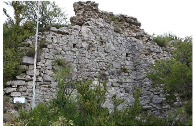
FIGURE 24 – SECTEUR 5 - MUR 1 - VERS LE NORD
