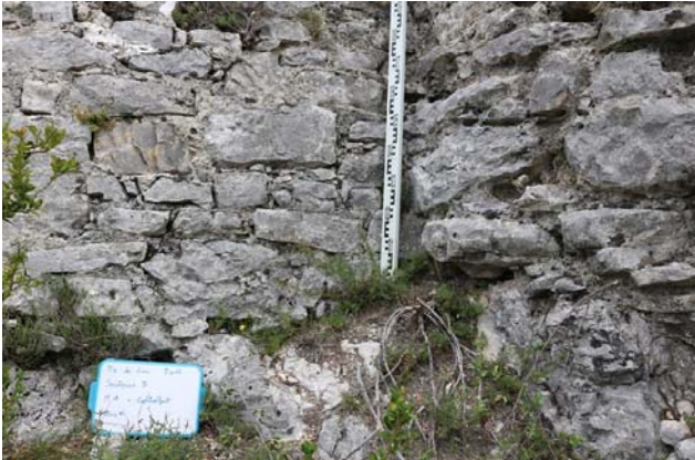
FIGURE 25 – SECTEUR 5 - MUR 1 ET CONTREFORT SUR LE ROCHER
