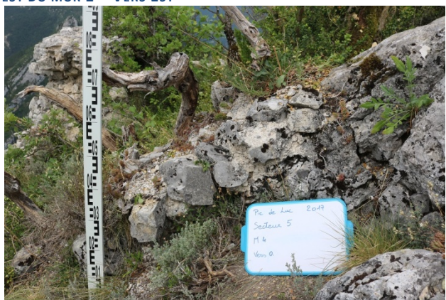
FIGURE 29 – SECTEUR 5 - MUR 4 - VERS OUEST
