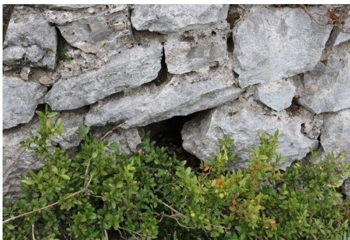
FIGURE 16 – SECTEUR 2 - TROU DE BOULIN OU BARBACANE SUR PAREMENT EXTÉRIEUR DU MUR SUD
