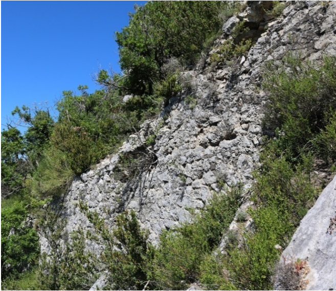
FIGURE 60 – SECTEUR 6 - MUR DE TERRASSE - VUE DEPUIS LE SUD-EST
