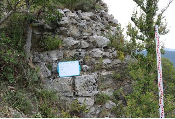
FIGURE 31 – SECTEUR 5 - MUR 1 -PAREMENT D'UN RETOUR VERS LE NORD - VERS EST
