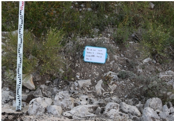
FIGURE 41 – SECTEUR 4 – MUR 2 / CUVES V ET X – VERS SUD
