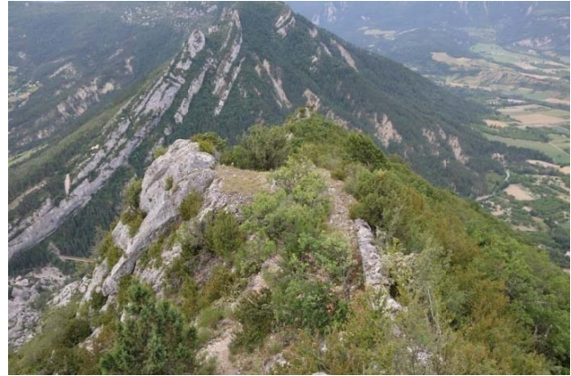
FIGURE 68 – SECTEUR 5 - MUR QUI LONGE LA CRÊTE - VERS OUEST
