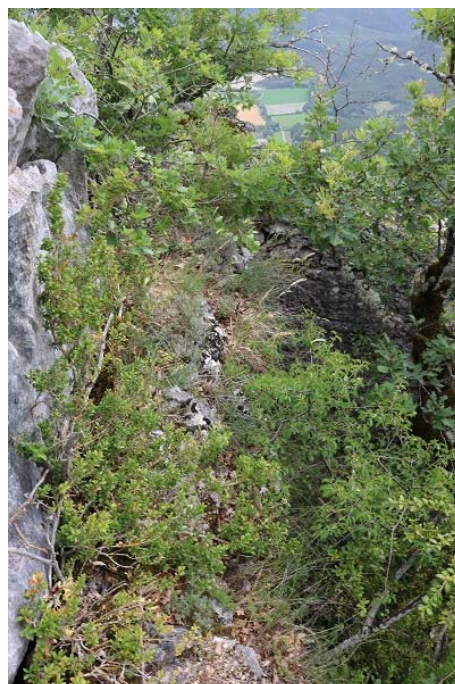
FIGURE 18 – SECTEUR 2 - MUR EST - VUE EN DIRECTION DU SUD
