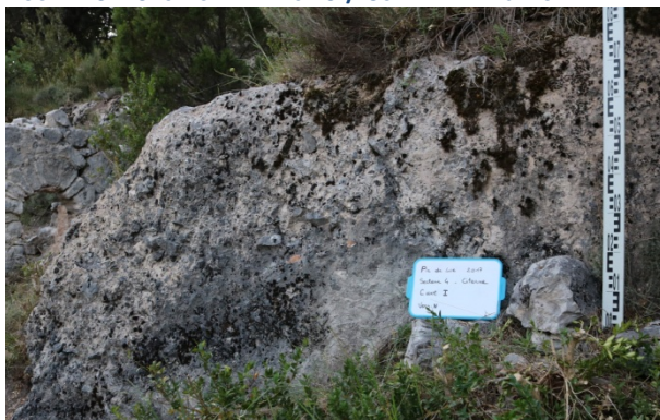
FIGURE 44 – SECTEUR 4 - MUR 1 / CUVE I - VERS NORD
