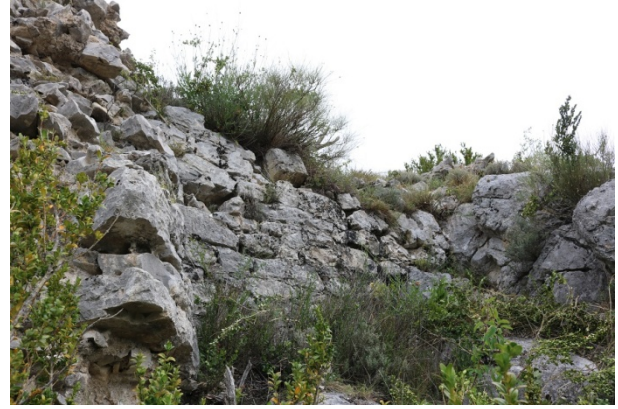
FIGURE 32 – SECTEUR 5 - MUR 1 APPUYÉ SUR LE ROCHER À L'EST - VERS NORD-EST
