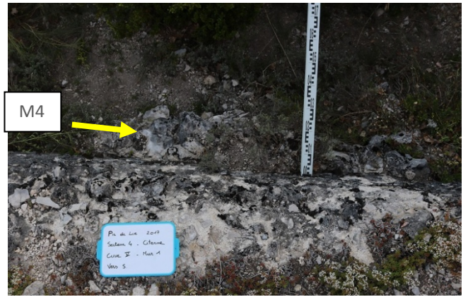
FIGURE 40 – SECTEUR 4 - MUR 1 / CUVE V - VERS SUD
