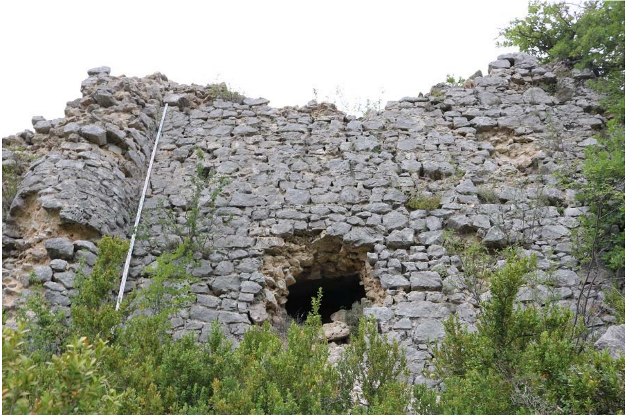
FIGURE 20 – SECTEUR 2 - PAREMENT EXTÉRIEUR DU MUR SUD (MIRE DE 5 M)
