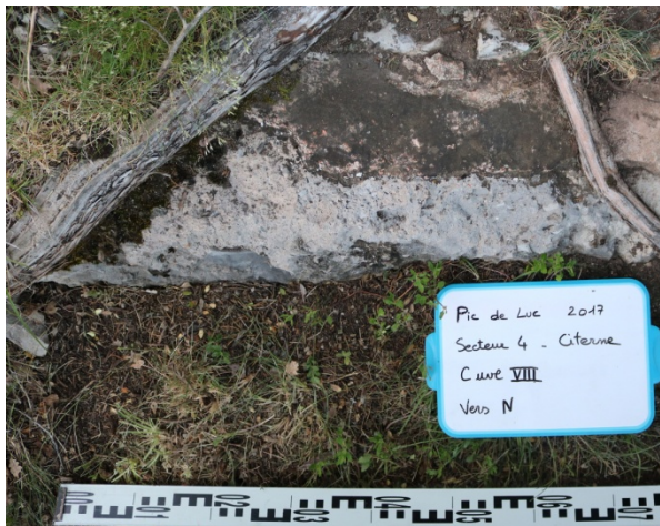
FIGURE 49 – SECTEUR 4 - BÉTON CUVEE VIII - VERS NORD
