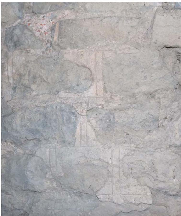
**FIGURE 83 – MUSÉE DE L'ANCIEN ÉVÊCHÉ - MORTIER DE TUILEAU AVEC JOINTS TRACÉS AU FER EN PAREMENT**
