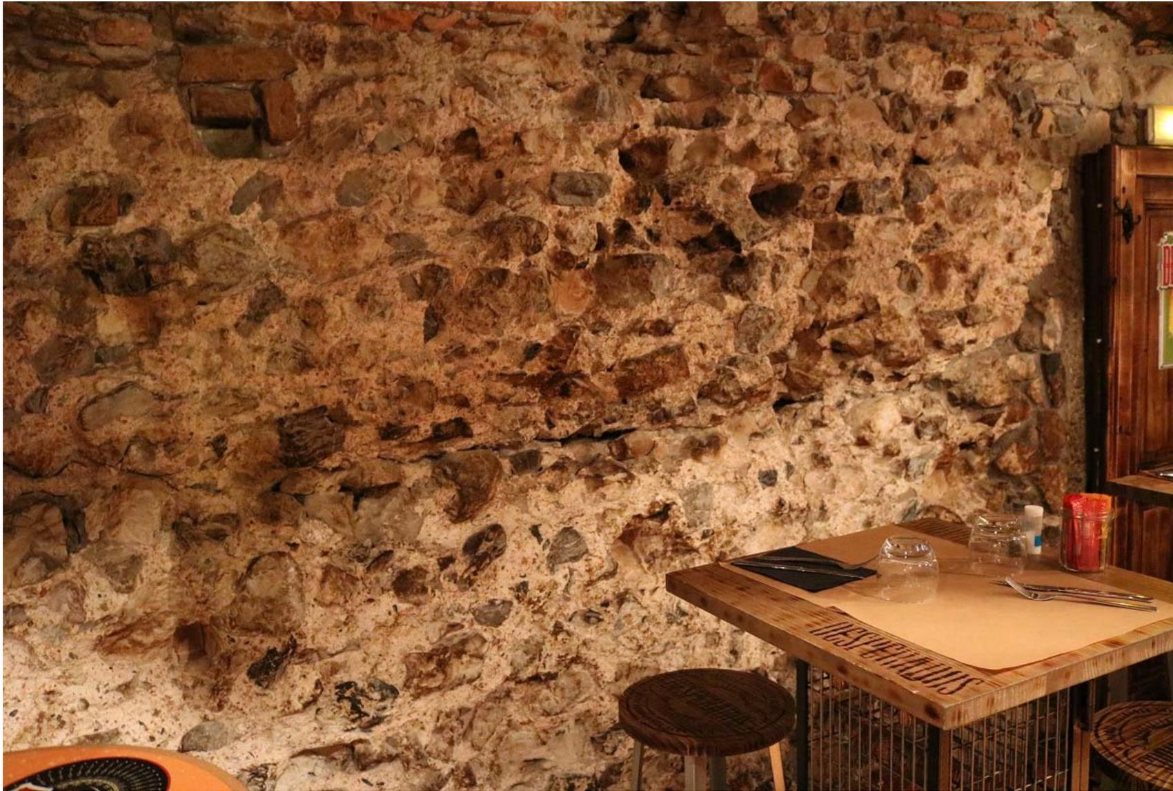
FIGURE 31 - N°6 PLACE NOTRE-DAME - BANCHÉE VISIBLE DANS LE BLOCAGE
