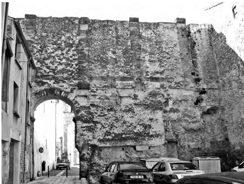
Fig. 16. Mur de la rue Pontillac, parement oriental, état actuel (cl. J.-M. Mignon).
