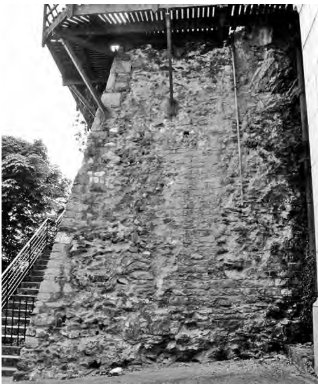
Fig. 7. Mur de soutènement antique caché par un parement taluté moderne, à l'est de la basilique (cl. Dj. Fellague).
