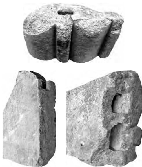
Fig. 17. Placages de colonne avec mortaises aux extrémités ou sur le côté, conservés au musée Saint-Raymond (cl. D. Cazes).
