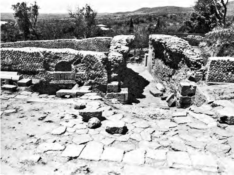
Fig. 12a. Evacuation des eaux et des hommes : cliché sur la limite ouest du forum (Gros 1981, 57).
