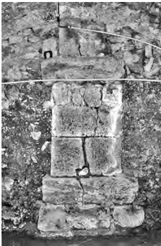
Fig. 40. Esplanade dallée : piédestal, place aux Herbes (cl. J.-M. Mignon).
