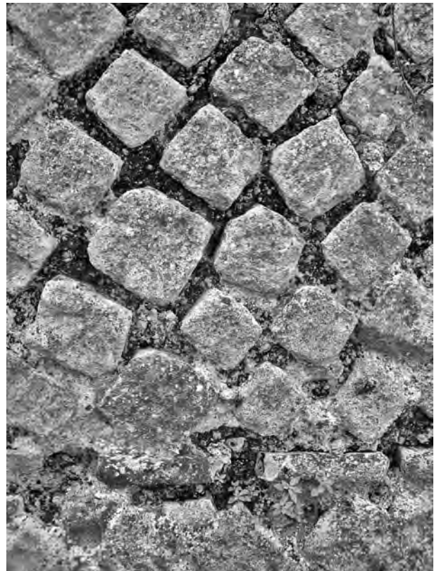
Fig. 7b. Paroi interne sud du passage voûté : quasi réticulé et ligne de briques (cl. J.-M. Pailler, 2010).
