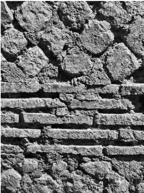
Fig. 7a. Paroi interne nord du passage voûté : réticulé et quintuple ligne de briques (cl. J.-M. Pailler, 2010).
