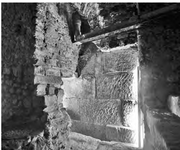
Fig. 4. Apt. Parcelle AV270 : détail de l'architecture de l'élévation antique et de la voie cardine. (cl. P. De Michèle 2008).
