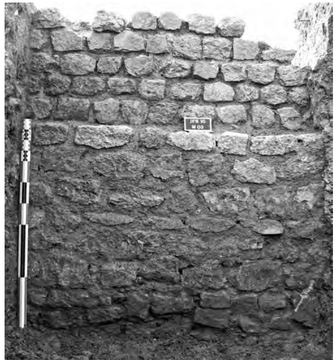
Fig. 6. Exemple de mur à appareil régulier de moellons de granite/granulite liés au mortier de chaux : mur (M.03) des boutiques orientales du forum (tranchée 1, est) (cl. PCR Javols- Anderitum ).
