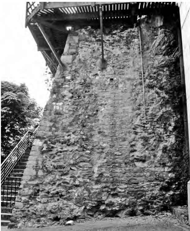
Fig. 7. Mur de soutènement antique caché par un parement taluté moderne, à l'est de la basilique (cl. Dj. Fellague).
