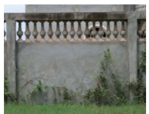
Balustres de sections circulaires
