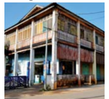
Galerie (bâtiment avec galeries)
