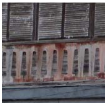
Garde-corps en bois
