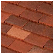
Couverture tuile mécanique plate
