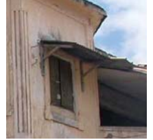
Auvent (sur fenêtre)
