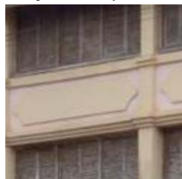
Garde-corps en maçonnerie pleine
