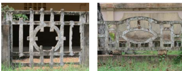
Clôtures en ciment armé d'origine à préserver
