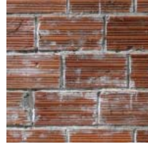
Mur brut brique creuse
