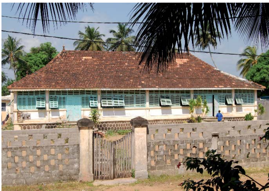
□ Maison Diaw (zone résidentielle, construite en 1910)
