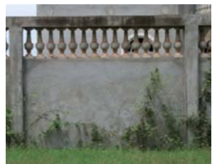
Balustres de sections circulaires
