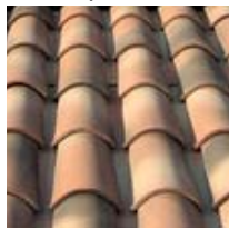
Couverture tuile céramique canale
