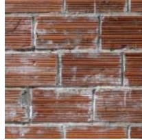
Mur brut brique creuse
