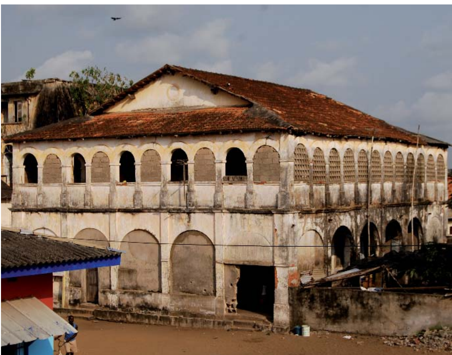
□ Maison Varlet (construit en 1918)
