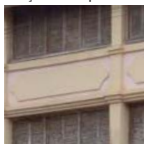
Garde-corps en maçonnerie pleine
