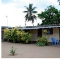
Maison à cour commune
