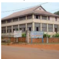
Véranda (bâtiment à véranda)
