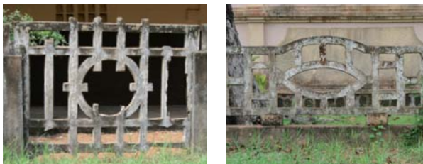
Clôtures en ciment armé d'origine à préserver
