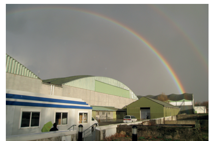
Figure 1. Locaux de Francazal.
