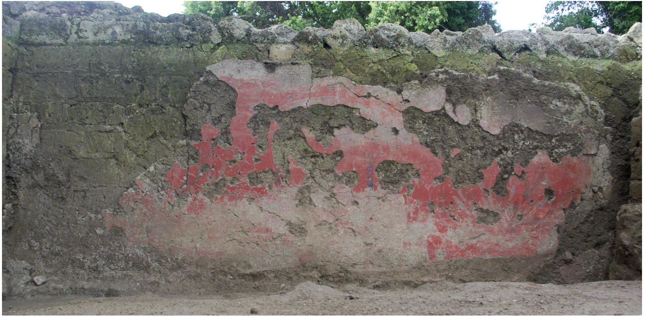
◆ Fig. 4. Mur sud (MR42002) avec l'enduit peint situé à l'est (42089) (cl. D. Neyme).
