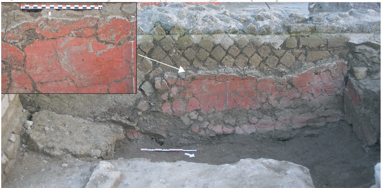
◆ Fig. 6. Mur sud (MR42002) avec l'enduit peint situé à l'ouest (42039) et zoom du motif en haut à gauche (cl. D. Neyme).
