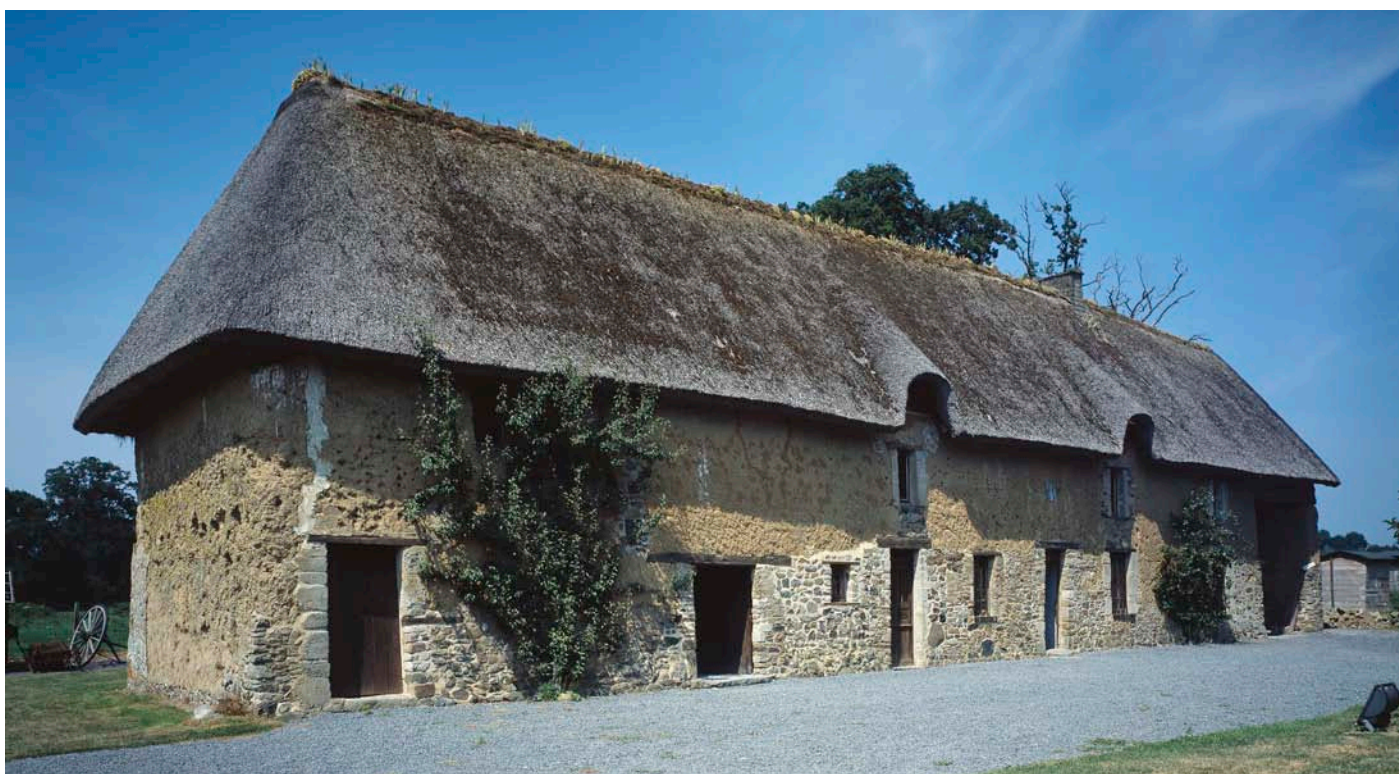
Ferme en bauge.
