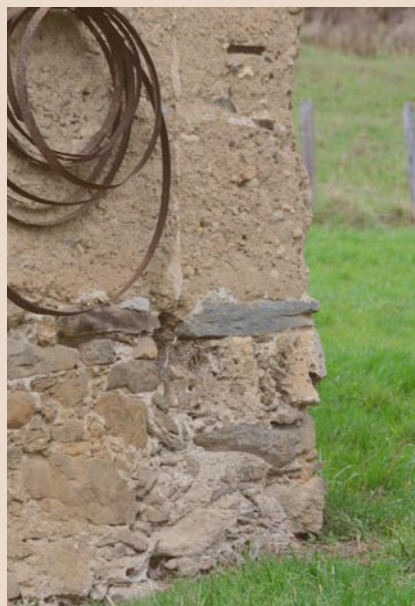
Un soubassement de hauteur suffisante et non recouvert de revêtement étanche permet aux remontées capillaires de ne pas atteindre le pisé.
