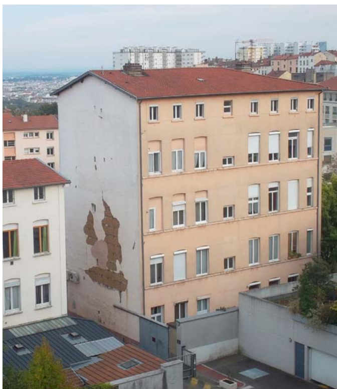
Immeuble en région lyonnaise : souvent assimilé au milieu rural, le pisé existe également en milieu urbain.
