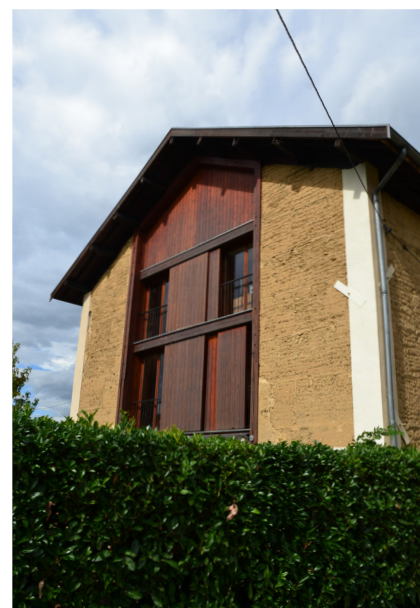
De nombreuses techniques existent pour réaliser une réhabilitation dans le respect de l'existant.
