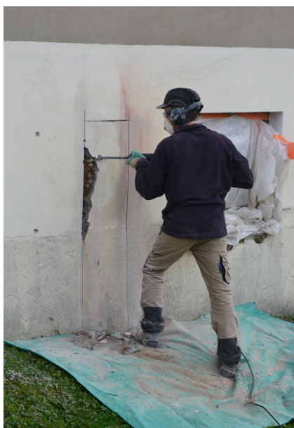
La réalisation de sondages et de dépose d'enduit sur bâti en pisé demande l'intervention d'artisans qualifiés.
