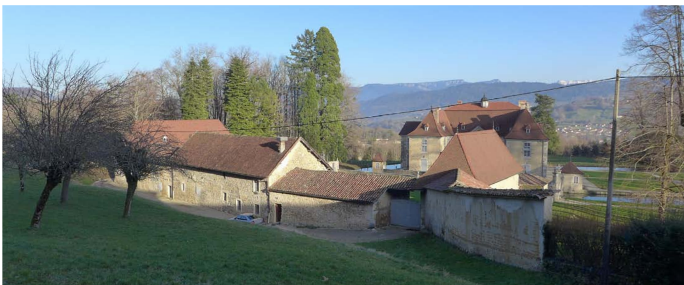
Les éléments de pisé au sein des ensembles bénéficiant d'une labellisation patrimoniale doivent pouvoir faire l'objet de travaux de restauration adaptés à la nature du matériau mais aussi à son histoire et sa qualité de témoignage.
