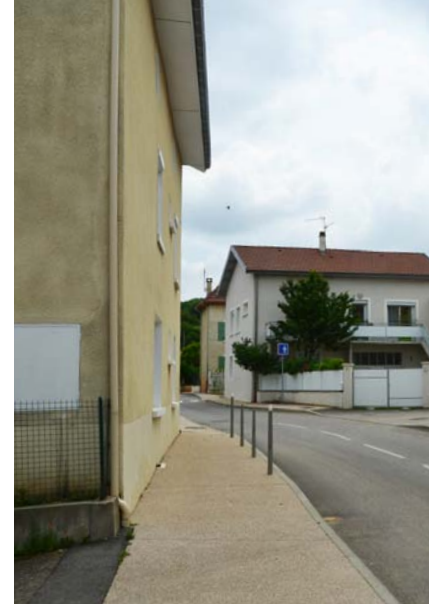
Comment aurait-on pu conserver l'identité du pisé dans la réhabilitation de ce centre bourg ?
