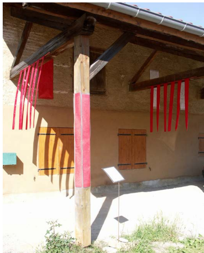
Façade de la Grange Porcher à Nivolas Vermelle suite à sa réhabilitation : les pathologies ont été traitées et les façades reprises à la terre.
