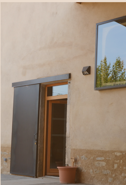
L'application d'un enduit de chaux selon les règles professionnelles permet aux parois de respirer tout en garantissant un fini esthétique.
