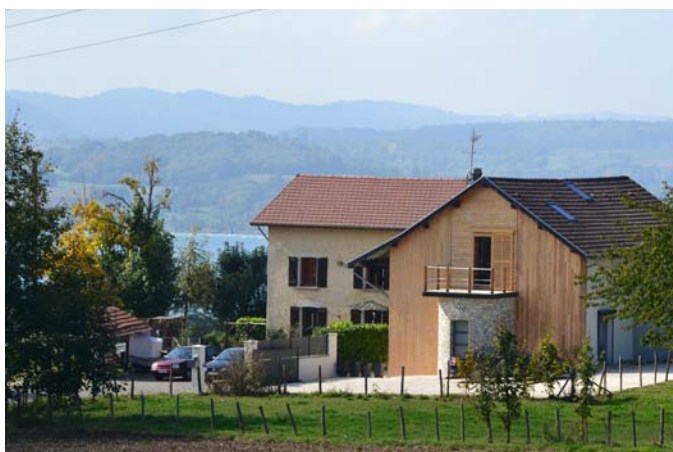
La valorisation de réhabilitation récentes et adaptées d'édifices en pisé est un catalyseur de projets, et donc d'activité économique locale.
