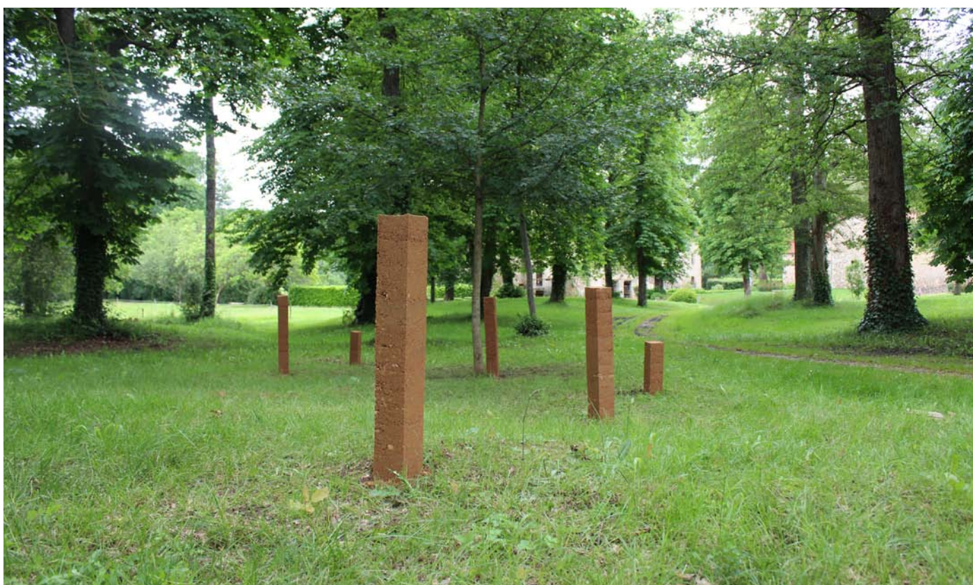
Réalisation de piliers en pisé lors d'un stage.
