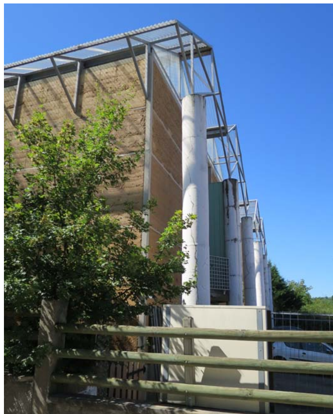
Utilisation contemporaine du pisé au Domaine de la Terre, architectes : Jourda et Perraudin.
