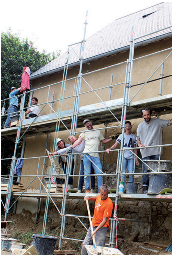
Chantier participatif de réhabilitation.
