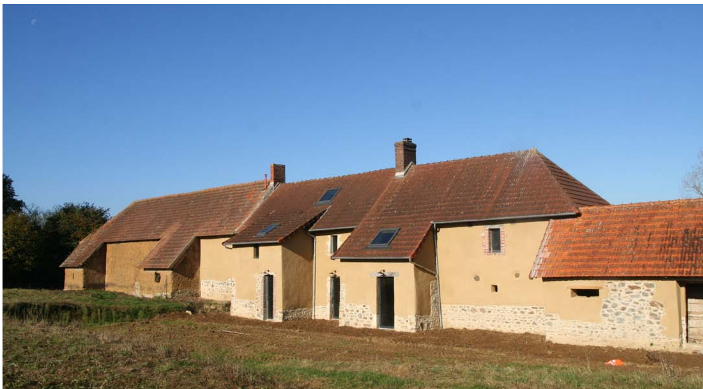
Ferme en bauge réhabilitée.
