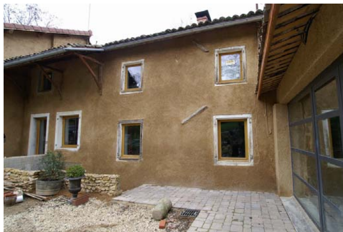
Les bâtiments en pisé nécessitent l'utilisation de savoir-faire et matériaux adaptés, créant ainsi un marché spécifique.
