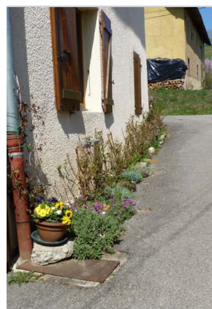
La végétalisation des pieds de murs peut générer des trop plein d'eau fragilisant les édifices.
