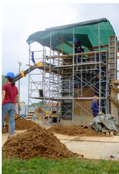
Réalisation des murs en pisé de la Maison pour Tous de la Commune de Four.
