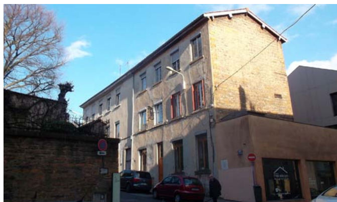
Immeuble de trois niveaux, montée de Loyasse, Lyon 5°.
