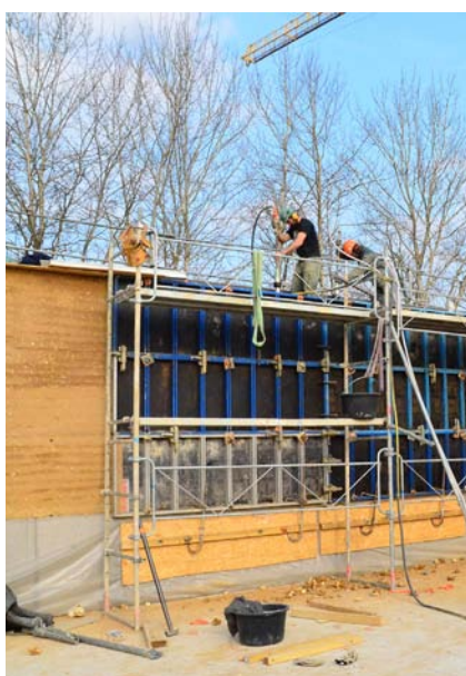
Chantier du conservatoire européen des échantillons des sols à Orléans.
