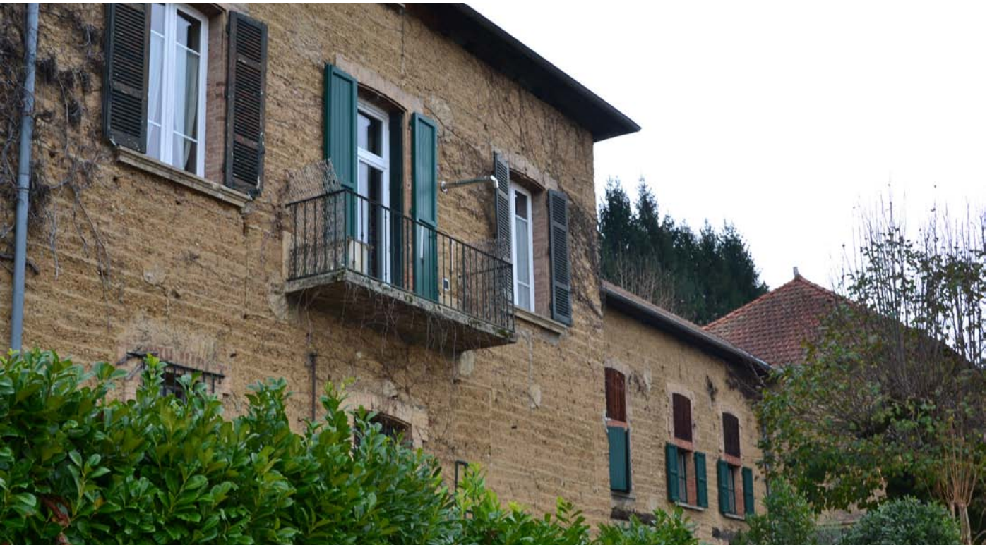
Comment préserver cet édifice remarquable mais privé et non situé dans un secteur bénéficiant d'une vigilance patrimoniale ?
