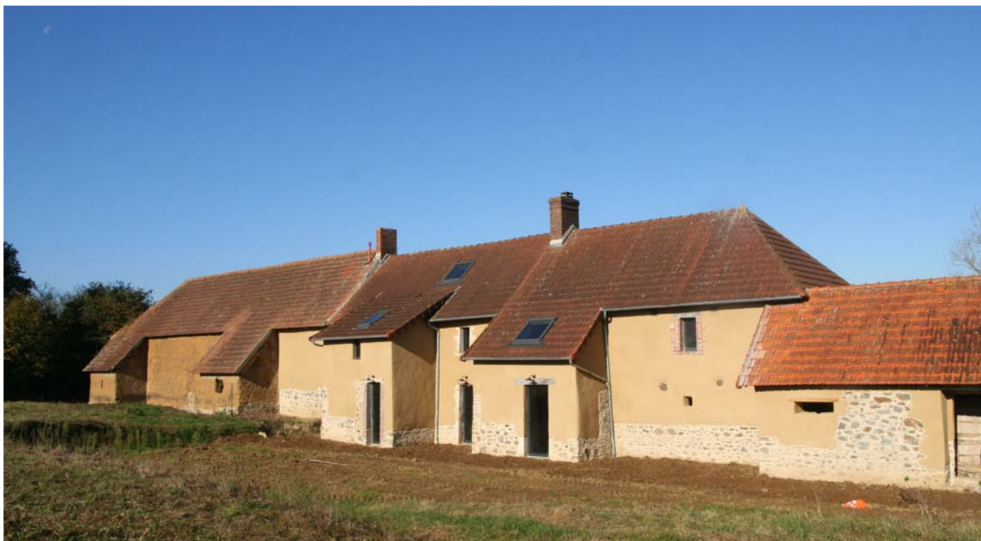
Ferme en bauge réhabilitée.
