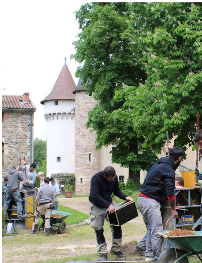
Réalisation d'éléments en pisé au château d'Aulteribe.
