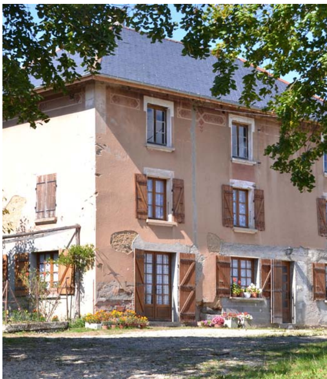
Demeure rurale enduite à la chaux et décorée de motifs réalisés a fresco (frises en sous toiture, faux chaînages d'angle).
