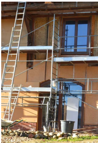
Les rénovations énergétiques sont à la croisée des enjeux structurels, d'usage et de qualité patrimoniale.
