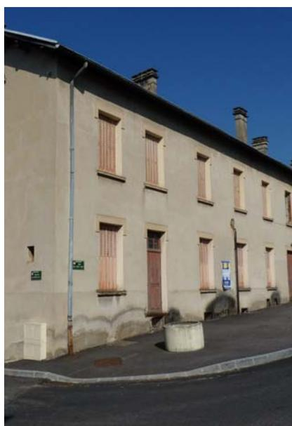
*Les rehausses étanches diminuent les hauteurs de soubassement et fragilisent les structures en pisé par l'action des remontées capillaires.*
