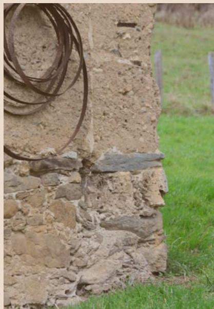
Un soubassement de hauteur suffisante et non recouvert de revêtement étanche permet aux remontées capillaires de ne pas atteindre le pisé.
