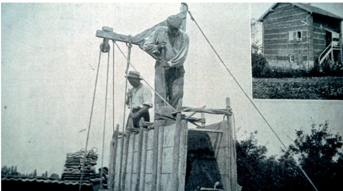
Maçons piseurs à l'oeuvre entre les banches, technique traditionnelle de construction en pisé de terre.
