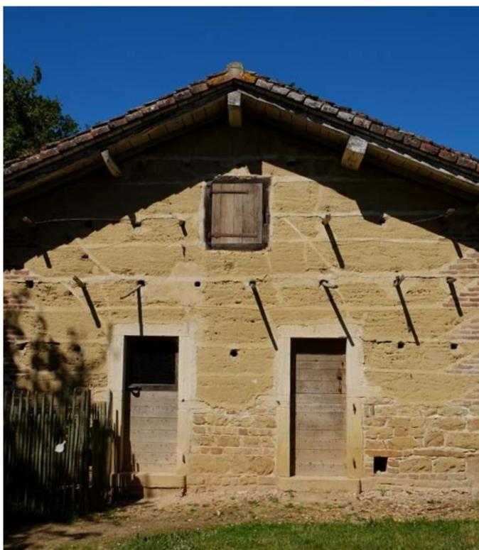
Utilisation du pisé sur soubassement en pierre et chaînage d'angle en briques cuites.
