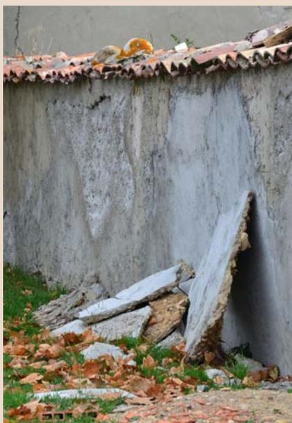
*L'application d'enduits non adaptés (ciment) favorise l'accumulation d'humidité dans le mur et participe à sa déstructuration.*
