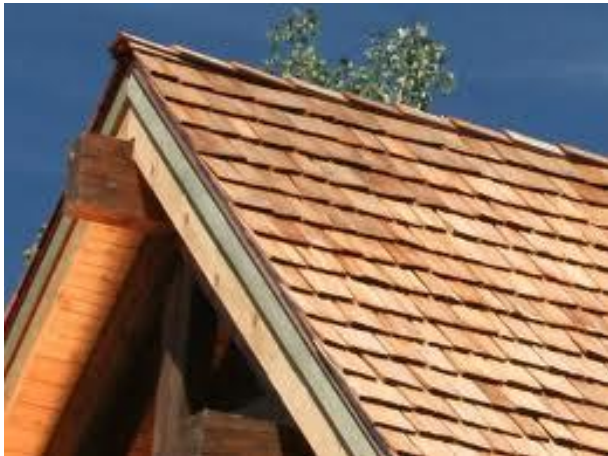
Bardeaux de toiture
