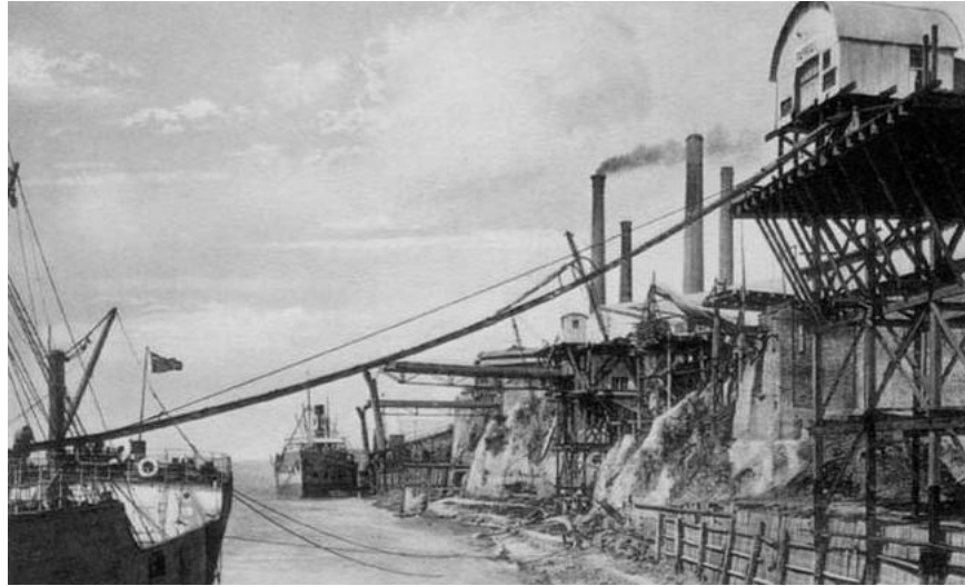
Figure 4: Chargement des navires par le système des "canaletas".
