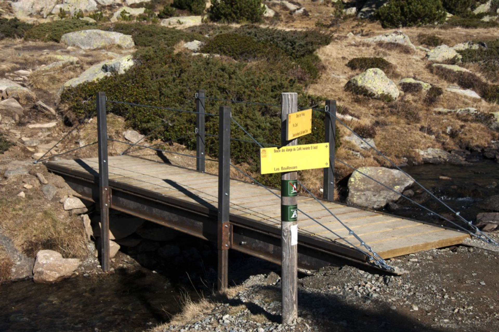
Construction d'un pont randonneurs pour contenir les passages à gué sur l'Estany de Vallell, site classé des Bouillouses, cliché Vlès mai 2016
