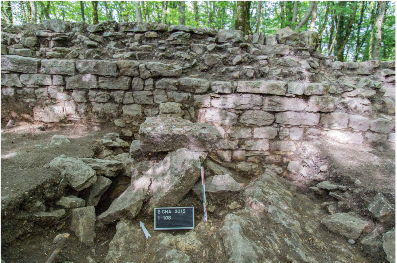
Figure 18. Vue des assises de pierres conservées et dégagées lors des fouilles en avril 2015. Cliché D. Daval – ODIT-CHEF 2015
