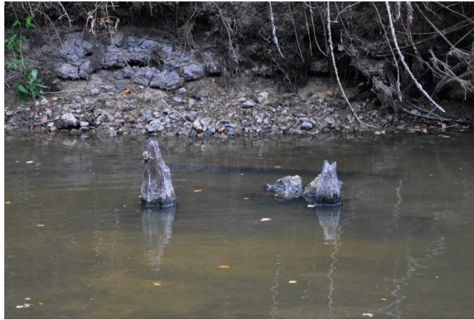
Figure 42 : Ensemble pc04, deux pieux alignés le long de la rive gauche, face à une bonde située rive droite. C. Laplaige
