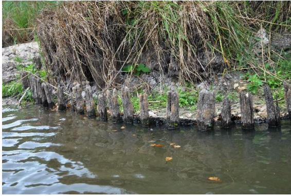
Figure 47 : Ensemble pc09, à droite en aval de la passerelle de la Canardière. A. Crozet
