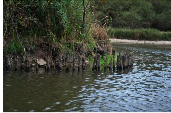
Figure 48 : Ensemble pc10, à gauche en aval de la passerelle de la Canardière. A. Crozet
