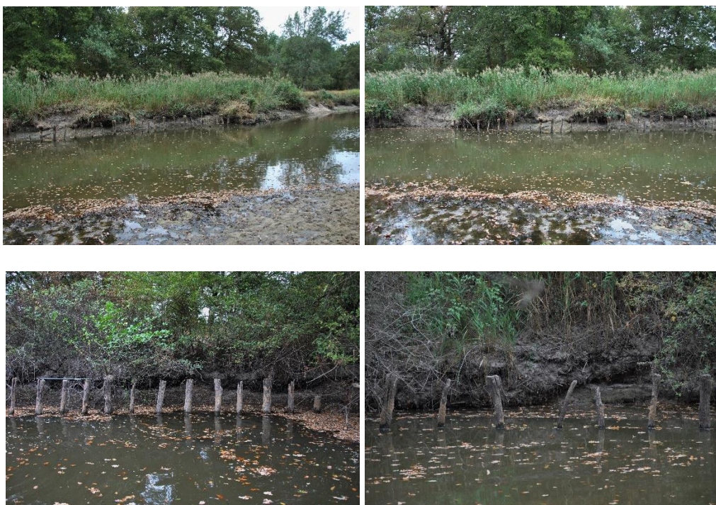
Figure 44 : Ensemble pc06, 83 pieux situés dans une zone plus profonde. A. Crozet
