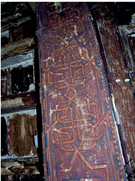
Figure 13 : sous face de la poutre du plafond de la maison du 1 rue Collot à Montpellier (vers 1260-1280). Entrelacs de style mudéjar. La peinture de ce plafond a été exécutée par le même atelier que celui qui a réalisé celle du plafond de l'ostal des Carcassonne. Photo Jean-Louis Vayssettes, SRA, DRAC Occitanie.
