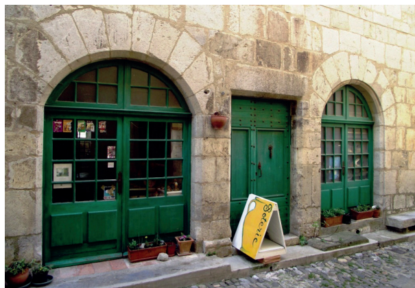
Figure 3 : arcades et porte du passage au rez-de-chaussée de la façade. Photo J. Foltran.
