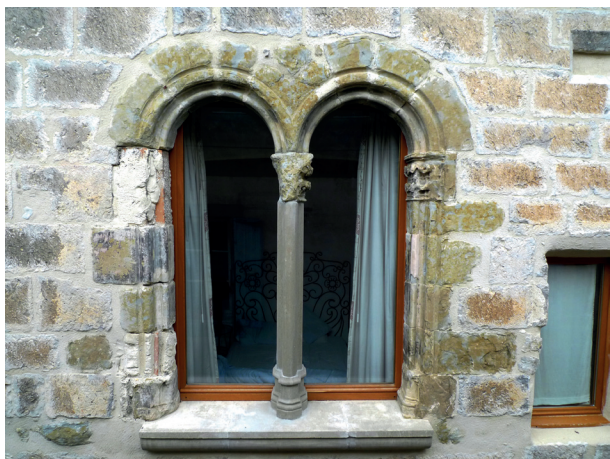
Fig. 13 : fenêtre géminée au premier étage de la façade. (Photo : J. Foltran)
