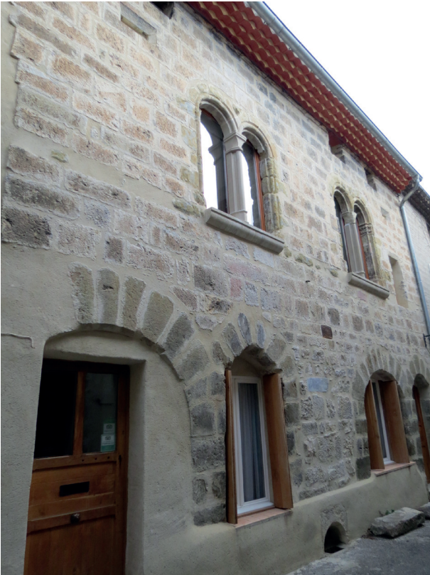
Fig. 11 : La façade sud, sur la rue des Cancans, vue depuis le sud-ouest. (Photo : J. Foltran)
