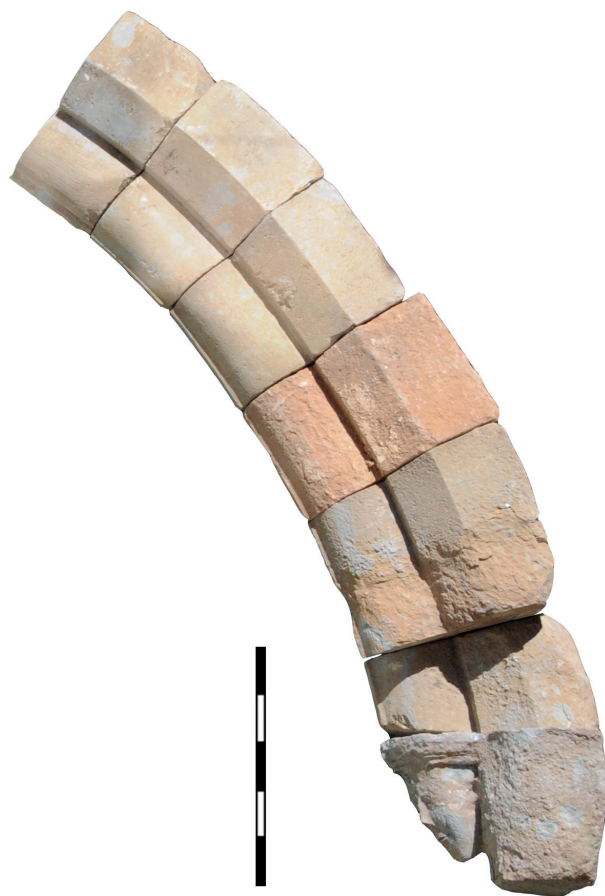
Fig. 16 : Reconstitution du départ de l'arc dont les claveaux étaient en remploi dans la maison. (Photo J.-P. Sarret)
