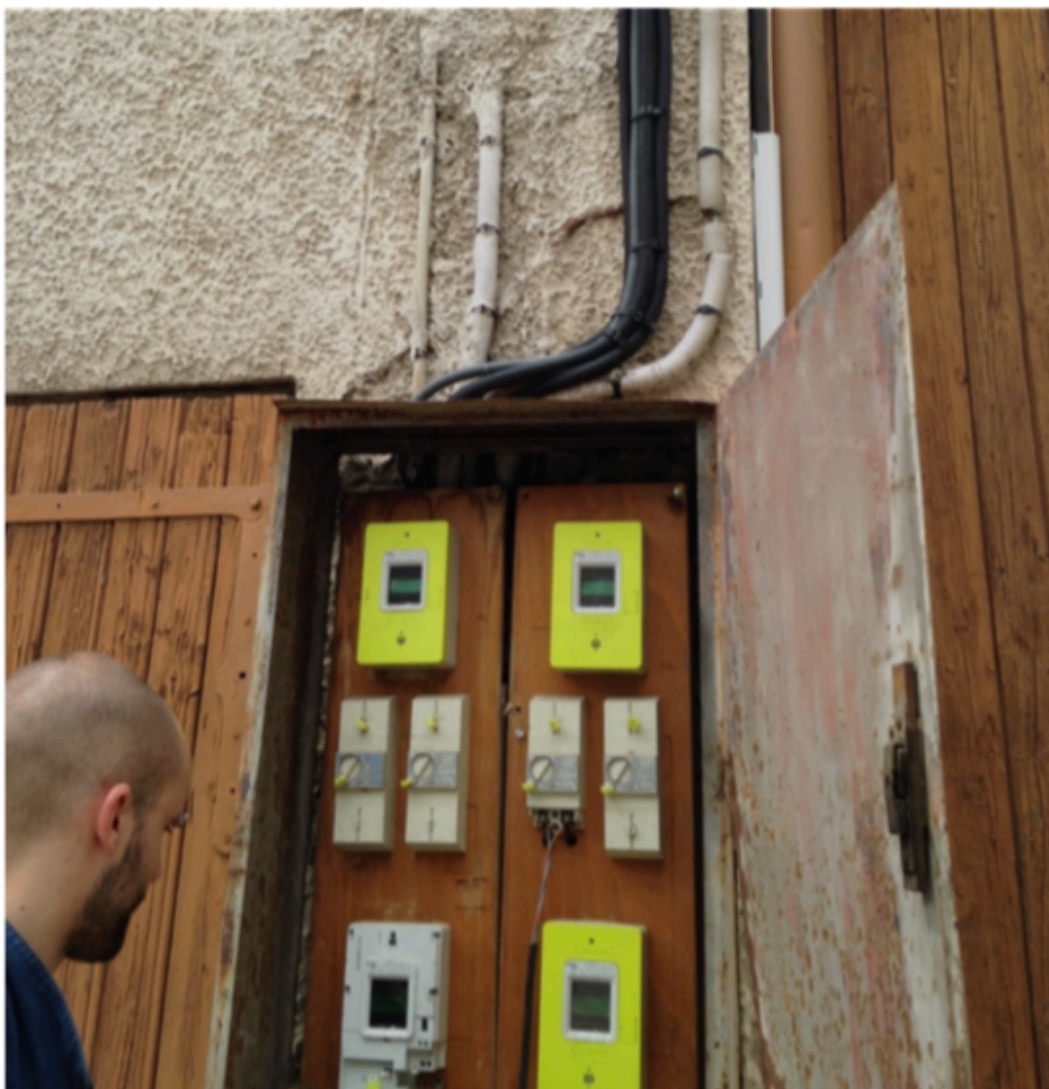
L'installation des appareils en extérieur des logements sans contact avec les clients. Quatre compteurs Linky raccordés dans la cour d'une copropriété, zone périurbaine, Caluire-et-Cuire, Grand Lyon, 21 mai 2014.
