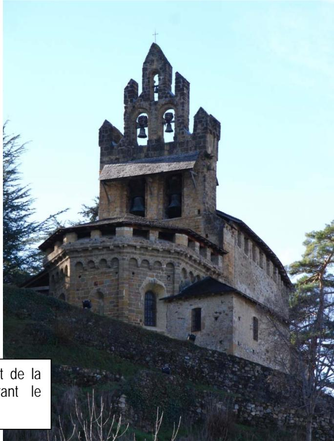
Fig. 7. Vue sur le chevet de la chapelle castrale montrant le surhaussement crénelé.
