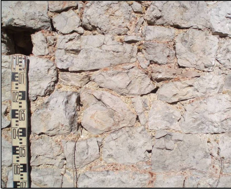
Intérieur mur nord (M1) de la tour maîtresse (détail, 1 X 1m).
