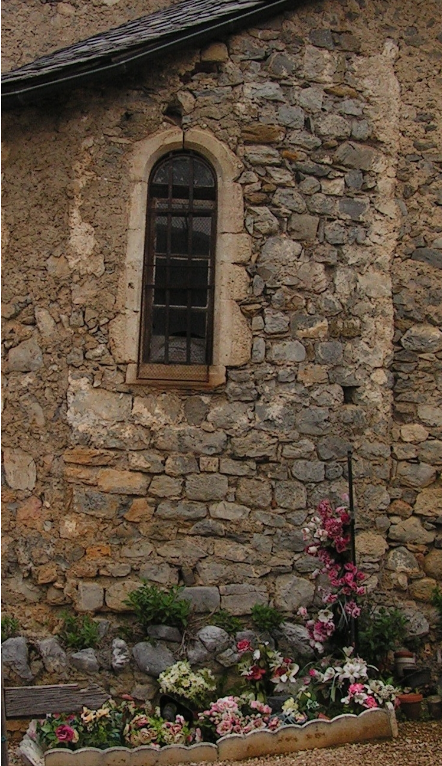
Fig. 7. Eglise de Balagué : parement roman du chevet (analogie avec M1 et M3 à M6).
