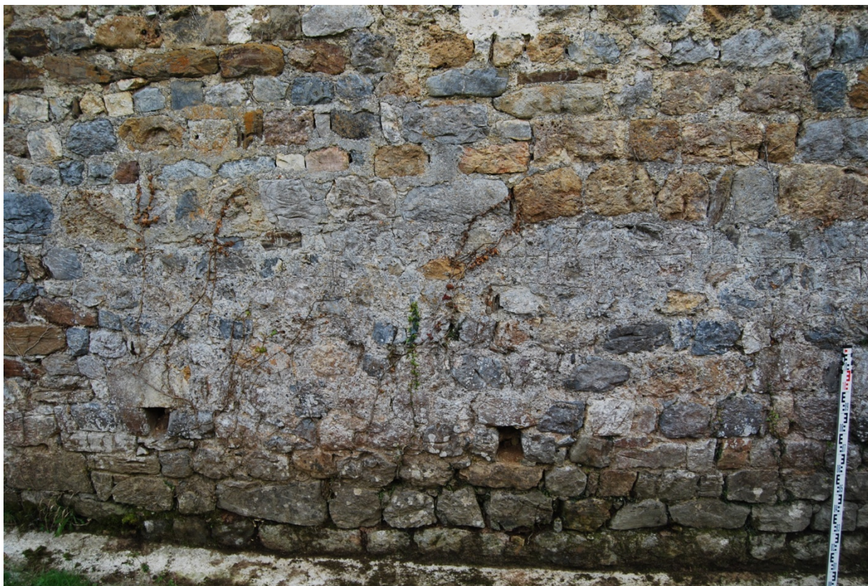
Fig. 6. Eglise d'Agert : parement roman du mur nord dans la partie basse (analogie avec M1 et M3 à M6).
