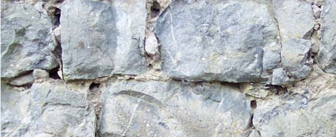
Fig. 8 – détail lit de pose
