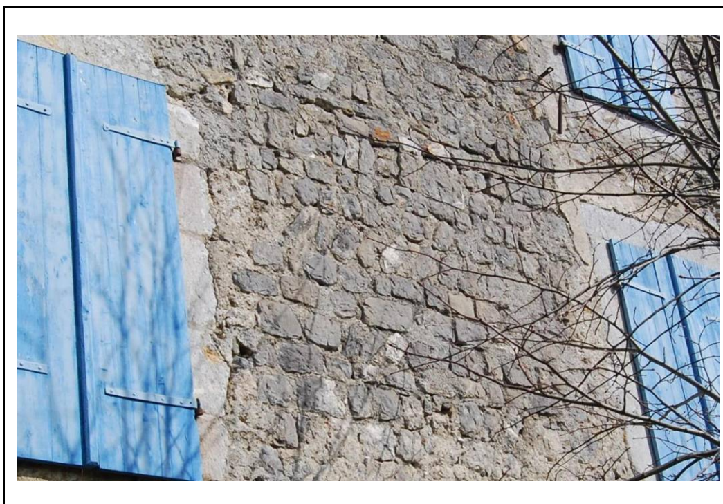
Fig. 7. Montégut-en-Couserans : détails parement extérieur M5.
