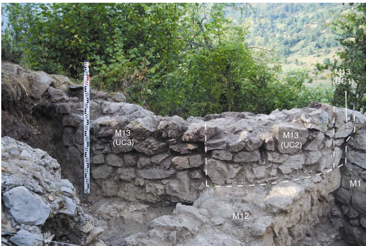
Fig. 10. Parement externe M13 depuis le sud.
