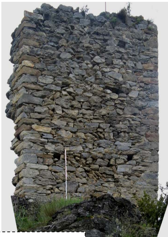
Face externe mur est
