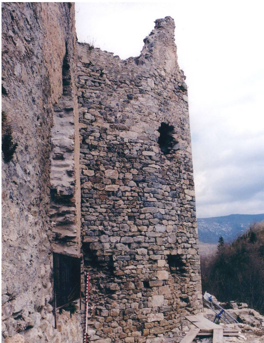
Fig. 6 – Photographie du parement 1 de M11 (1997, avant les travaux de restauration)
