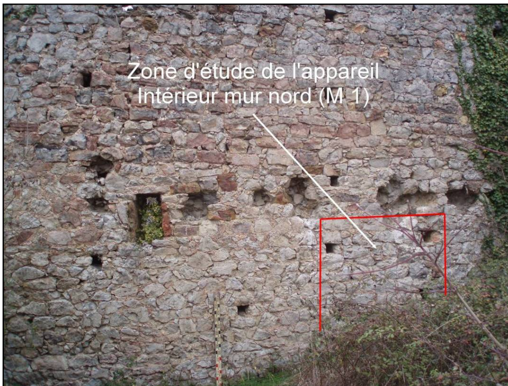
Intérieur mur nord (M1) de la tour maîtresse.
