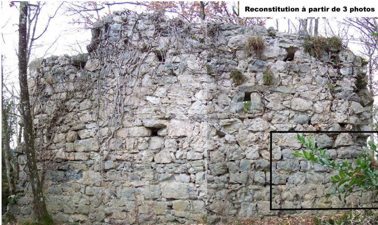
Fig. 7 - Façade sud-est de la tour maîtresse avec encadré développé en Fig. 9.
