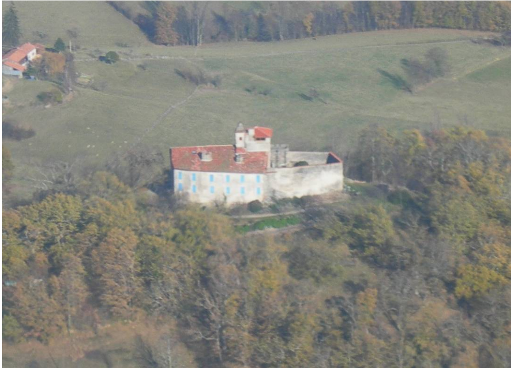
Fig. 4. Vue aérienne donnant sur la façade ouest du château de Montégut (photo Denis Mirouse 2006).
