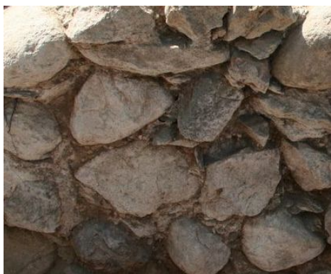
Extérieur est Mur 7
