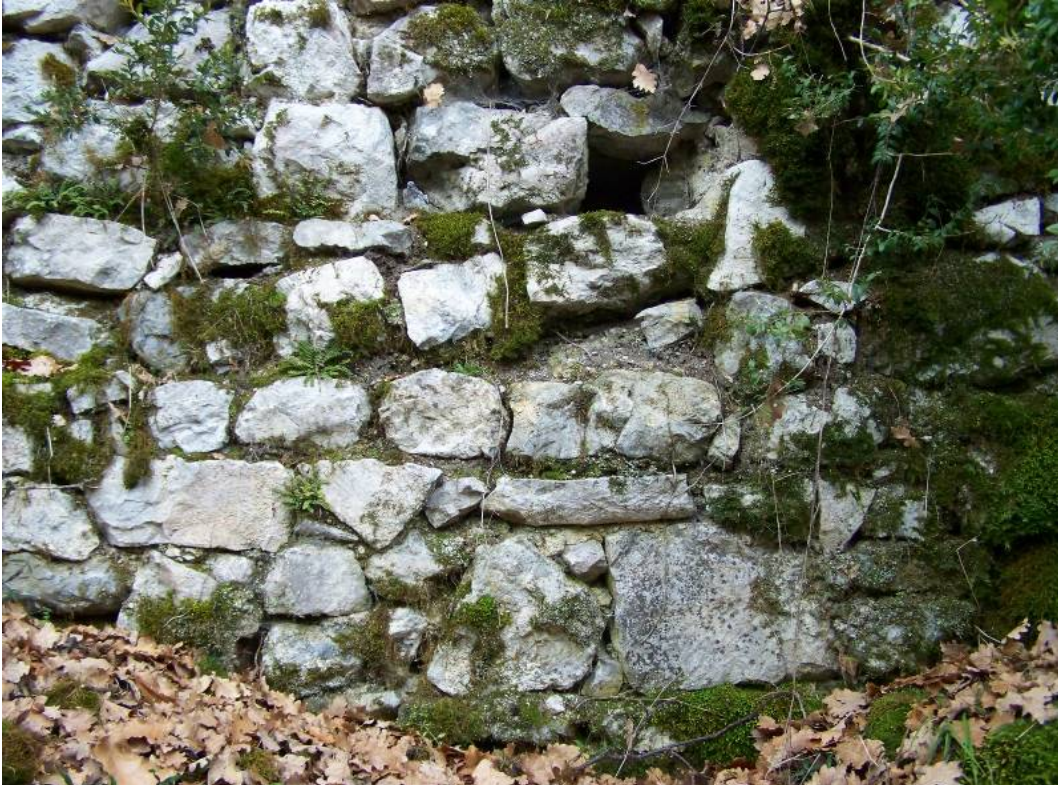
Fig. 11 – Parement intérieur de l'angle nord-est de l'enceinte.
