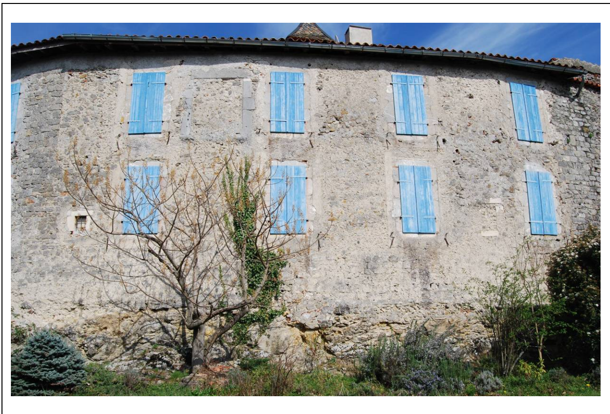
Fig. 8. Montégut-en-Couserans : parement extérieur M4.
