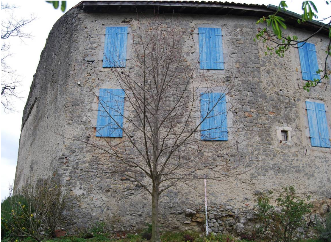
Fig. 9. Montégut-en-Couserans : parement extérieur M5.
