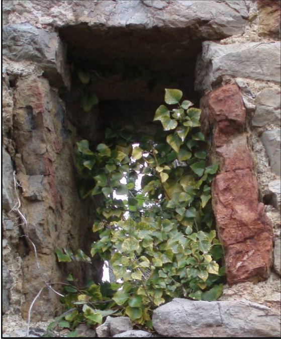
Ouverture mur M 1
