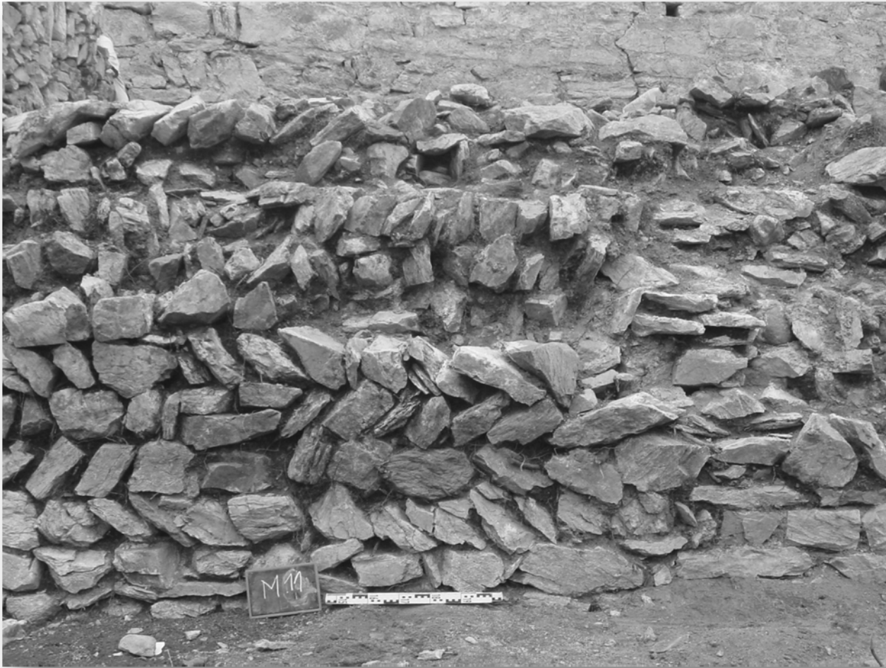
Parement interne de l'enceinte :
