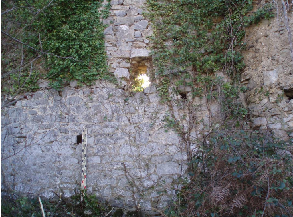
Extérieur mur nord (M1) de la tour maîtresse.
