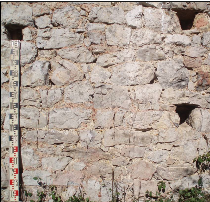
Intérieur mur nord (M1) de la tour maîtresse (détail, 2 X 2 m).
