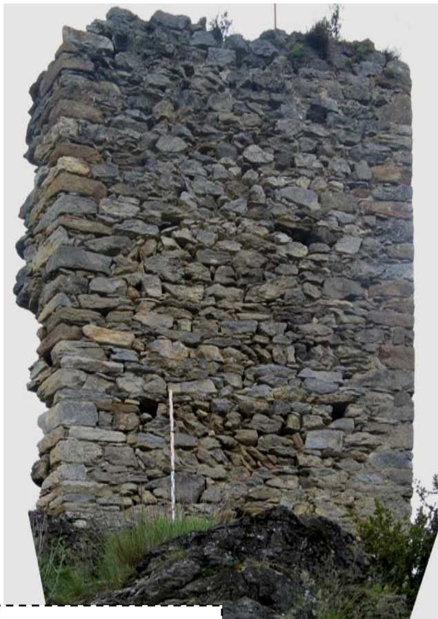
Face externe mur est
