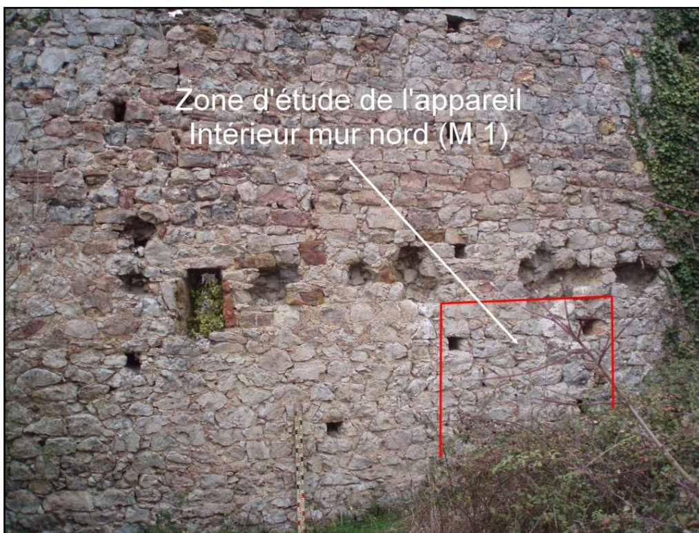
Intérieur mur nord (M1) de la tour maîtresse.
