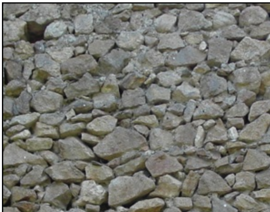
Mur 1 en élévation
