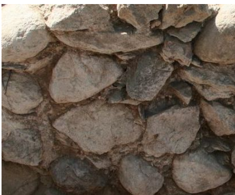
Extérieur est Mur 7
