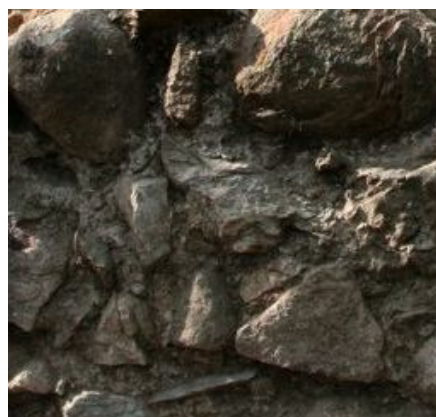
Extérieur nord Mur 4
