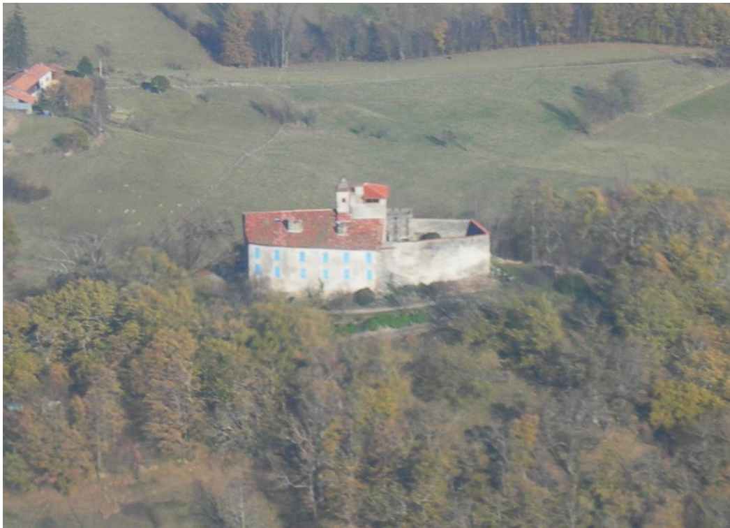
Fig. 4. Vue aérienne donnant sur la façade ouest du château de Montégut (photo Denis Mirouse 2006).
