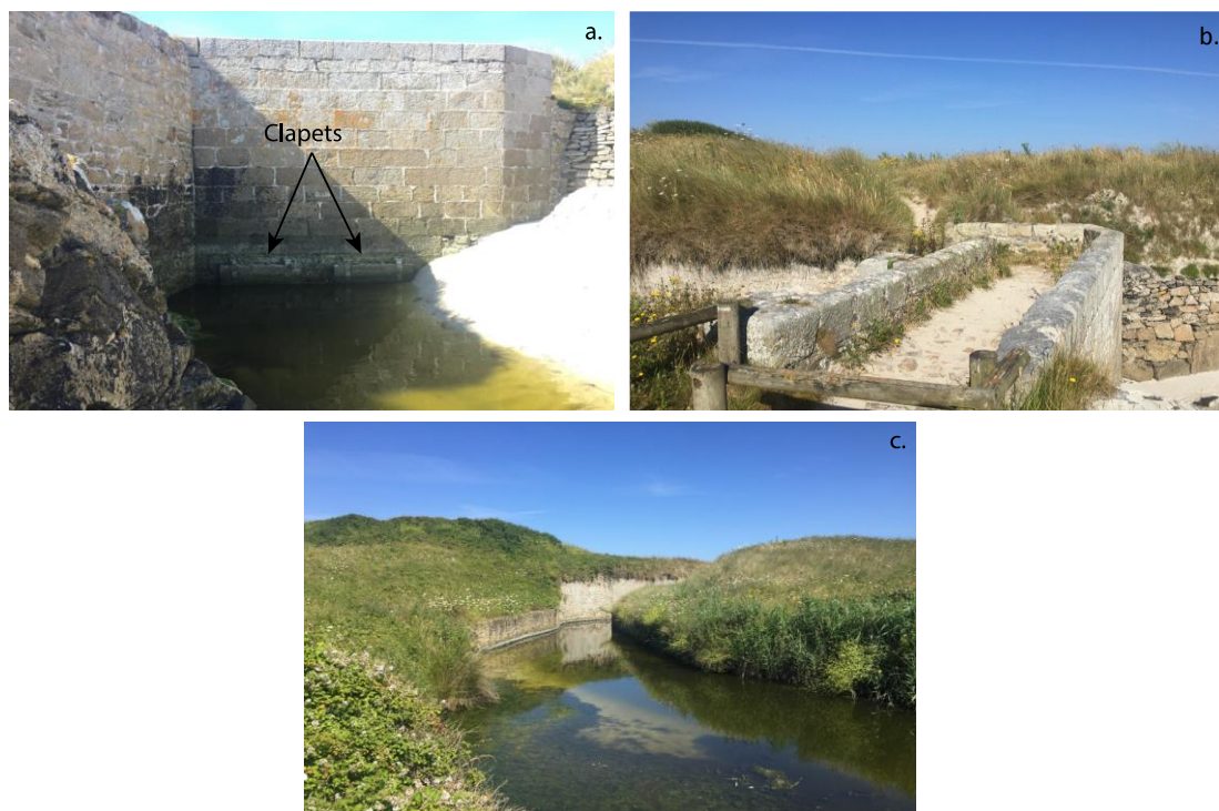
Figure 6. Photos de l'écluse : a. clapets côté mer, b. pont au-dessus des clapets, c. canal de l'écluse côté étang
