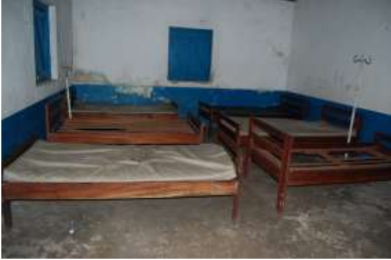
Photo 45 : Les lits de la salle d'hospitalisation du CSI de Mayama.
