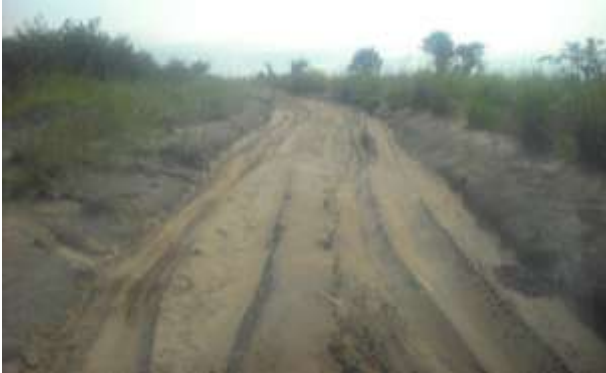
Photo 16 : Montée sableuse après Loumou (2) Déviation nécessaire pour éviter le pont endommagé de la Louala
