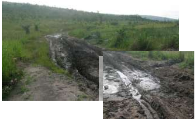
Photo 17 : Bourbiers dans les sols hydromorphes de fonds de vallée (3) Confluent Nguidi-Djouari, près de Louheto. en sortant de la déviation précédente.
