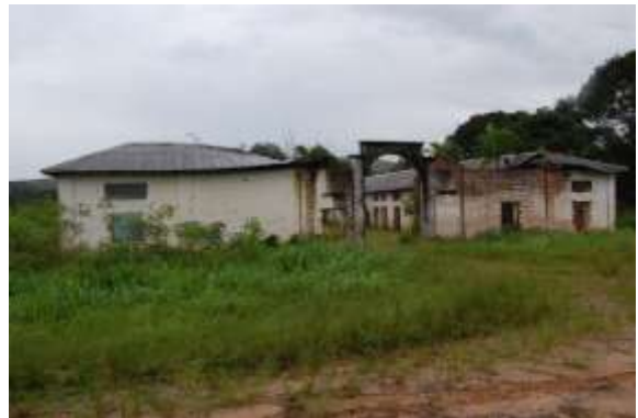
Photo 8 : Vestiges de la prison coloniale de Mayama.
