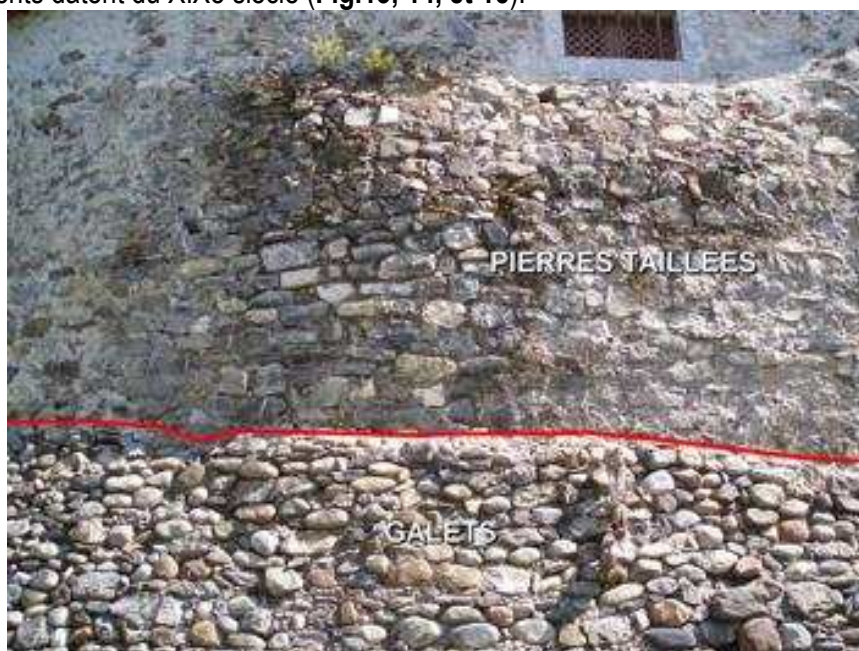
Fig. 13 Soutènement en galets (première enceinte, partie externe, face sud)
