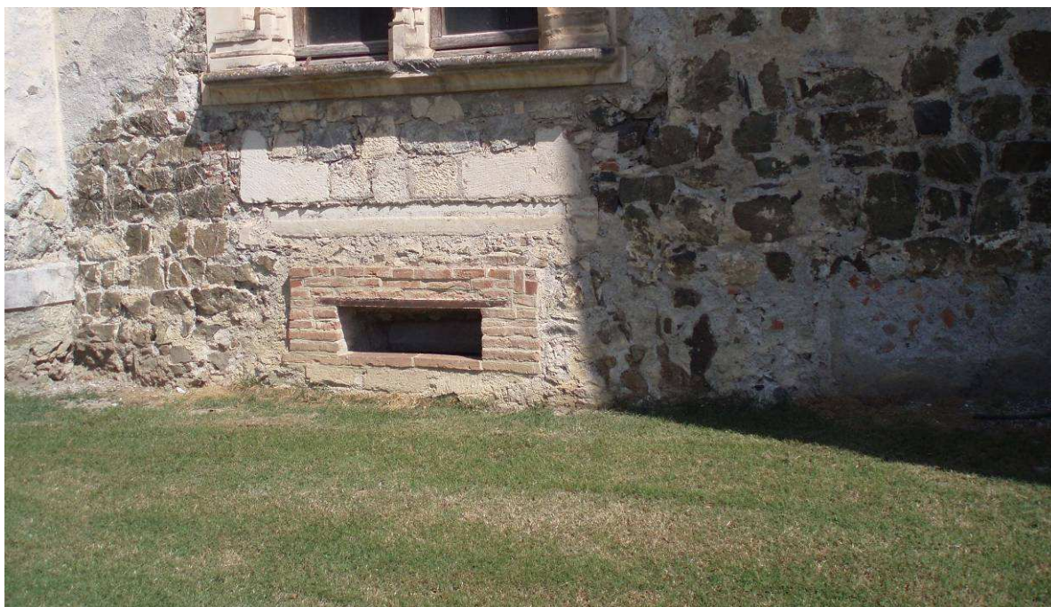
Fig. 12 Parement du corps de logis (face est)
