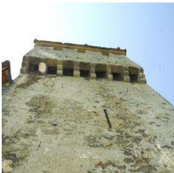
Fig. 48 Détail: meurtrière, mâchicoulis.
