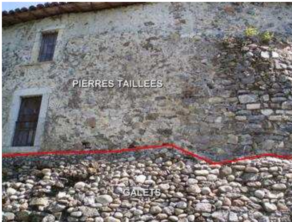
Fig. 14 Soutènement en galets (première enceinte, partie externe, face sud)
