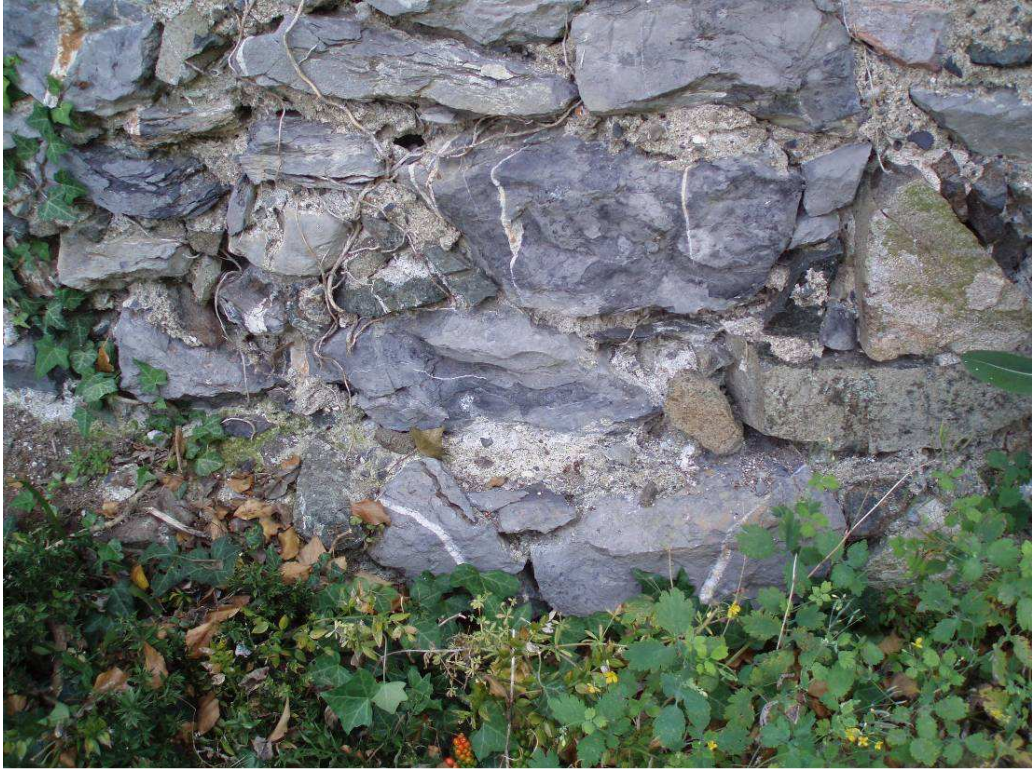
Fig. 10 Parement interne du premier mur d'enceinte (détail)
