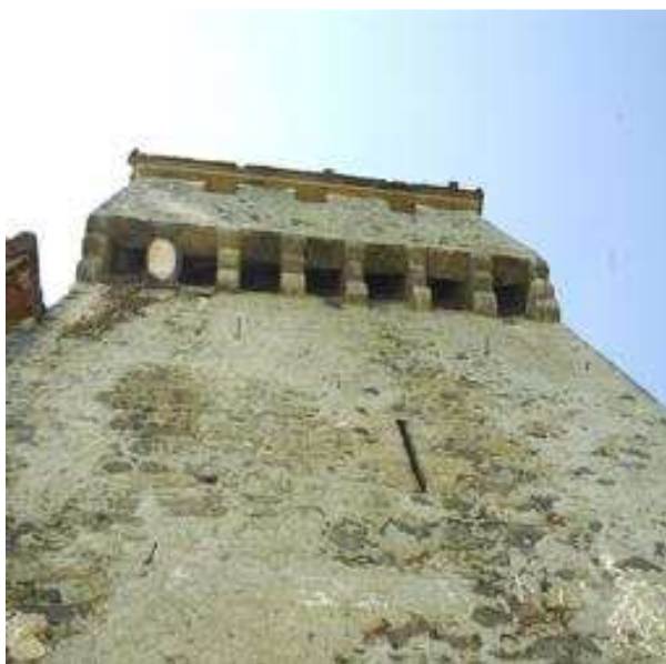
Fig. 48 Détail: meurtrière, mâchicoulis.
