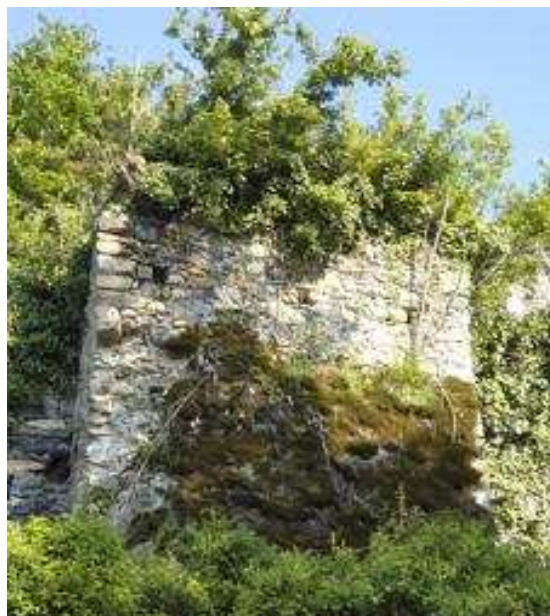
Fig. 42 Vue de profil. La base est talutée
