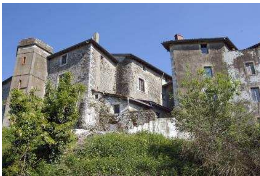
Fig. 35 Vue d'ensemble coté ouest.
