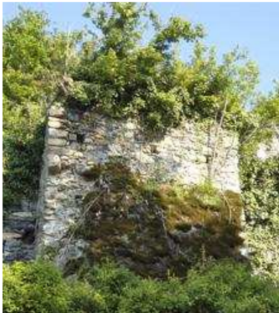
Fig. 42 Vue de profil. La base est talutée
