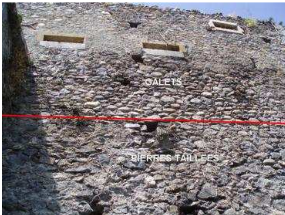
Fig. 15 Surélévation en galets (première enceinte, face est)
