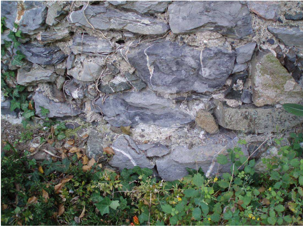
Fig. 10 Parement interne du premier mur d'enceinte (détail)
