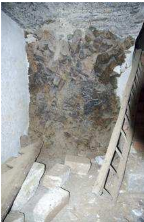
Fig. 37 Photo en sous sol de l'emplacement de la tour maîtresse
