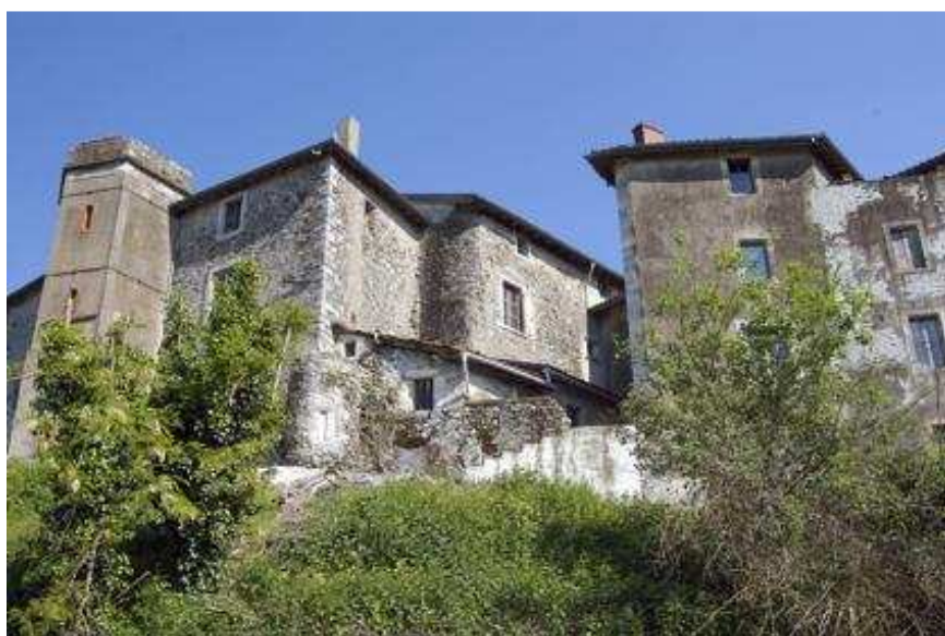
Fig. 35 Vue d'ensemble coté ouest.
