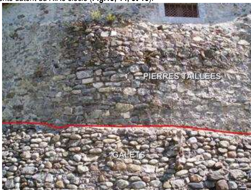
Fig. 13 Soutènement en galets (première enceinte, partie externe, face sud)
