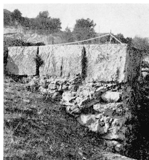
11 — Deux piles de fondation. A gauche, pile située à l'angle sud-est de la basilique, construite à l'air libre ; à droite, pile o , portique est, où la maçonnerie de moellons a été jetée en fosse. Cl. J. Bigot.
