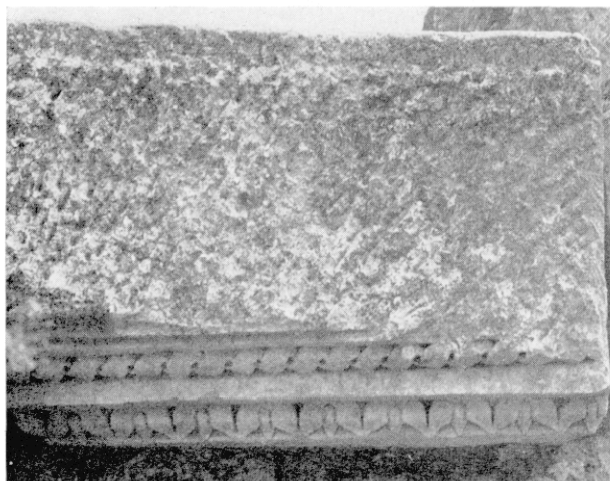
6 Un des blocs de corniche réemployé en libage dans les fondations de la clôture sud du forum ; les parties les plus saillantes (larmier et cimaise) ont été abattues.
