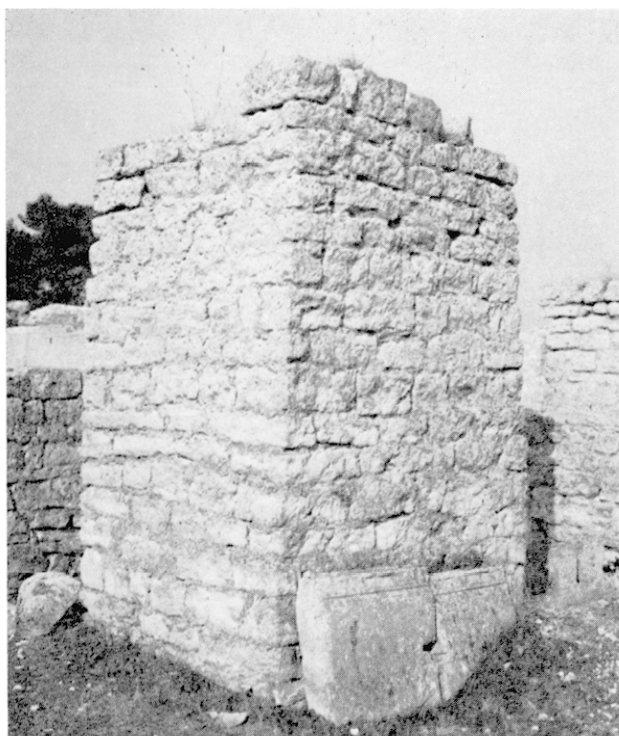
11 — Deux piles de fondation. A gauche, pile située à l'angle sud-est de la basilique, construite à l'air libre ; à droite, pile o , portique est, où la maçonnerie de moellons a été jetée en fosse. Cl. J. Bigot.
