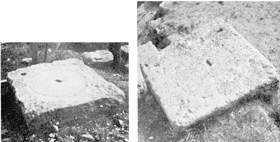
10 Deux dés de fondation du portique ouest. A gauche, dé i , avec le cercle très nettement délimité, en légère dépression, témoignant de la présence d'une colonne ; à droite, dé k , avec repères en T délimitant le cercle. Cl. J. Bigot.
