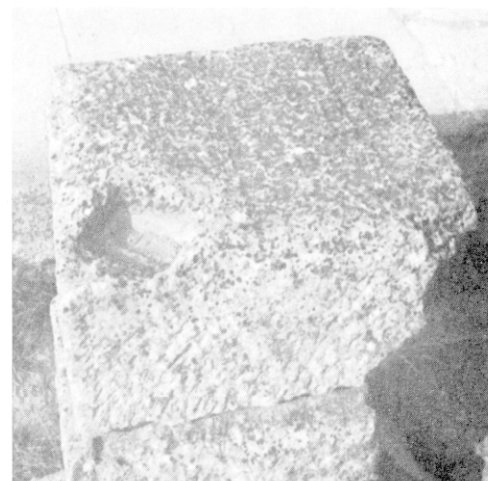
7 Bloc d'angle de corniche attribué à la basilique, avec encastrement de l'arêtier. Cf. J. Bigot.
