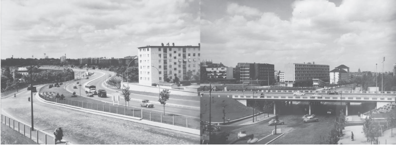
Figure 5. À gauche, boulevard périphérique-Sud, poterne des Peupliers, mai 1961 ; à droite, boulevard périphérique-Sud, pont, porte de Gentilly, mai 1961.
