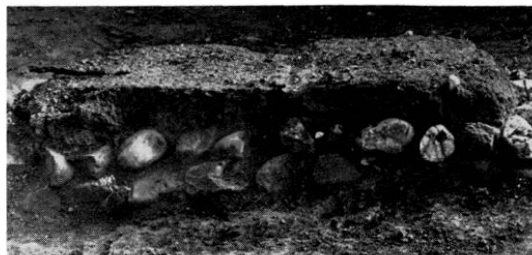
7 Vue de détail des briques et du soubassement de galets de l'abside
