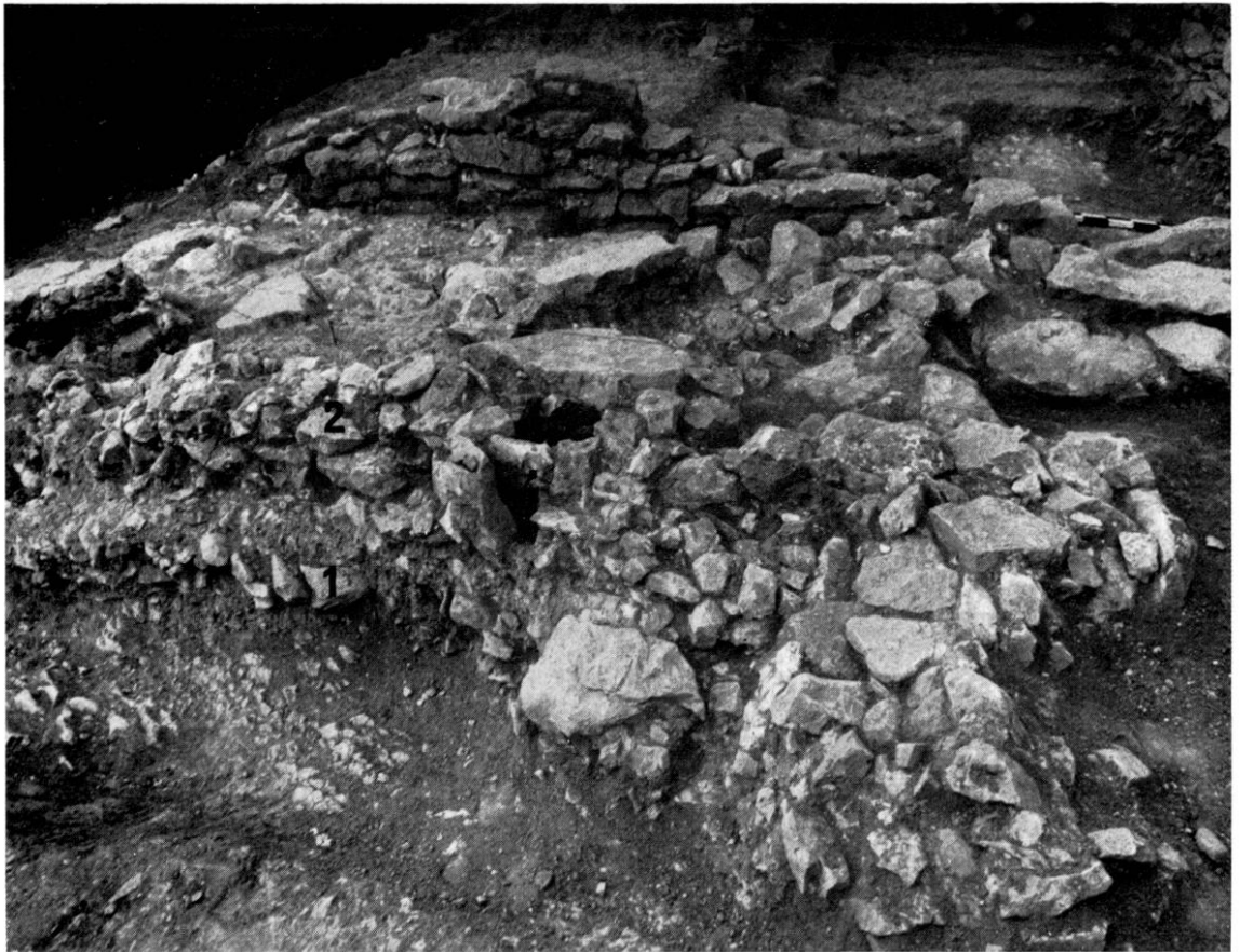
16 Les deux états du mur de l'escalier.
