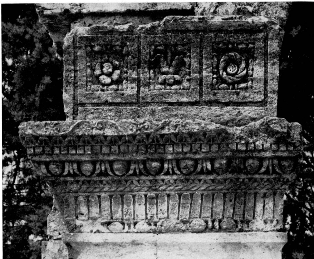
24 Pilastre sud-ouest, face est de l'imposte du tétrapyle de Cavaillon.
