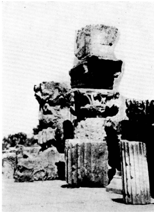
8. Glanum. Éléments architecturaux provenant d'un des temples jumelés.
