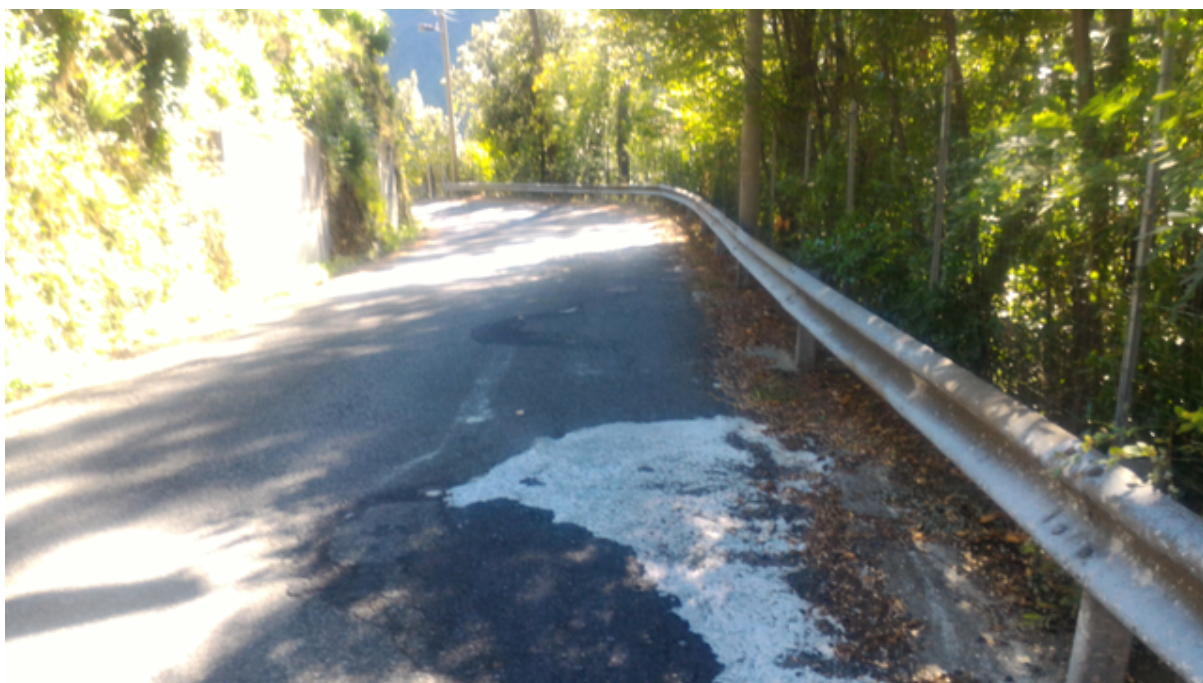
Figura 20: strada adiacente al cimitero, la fotografia rappresenta lo stato dei luoghi in data 3 ottobre 2018.
