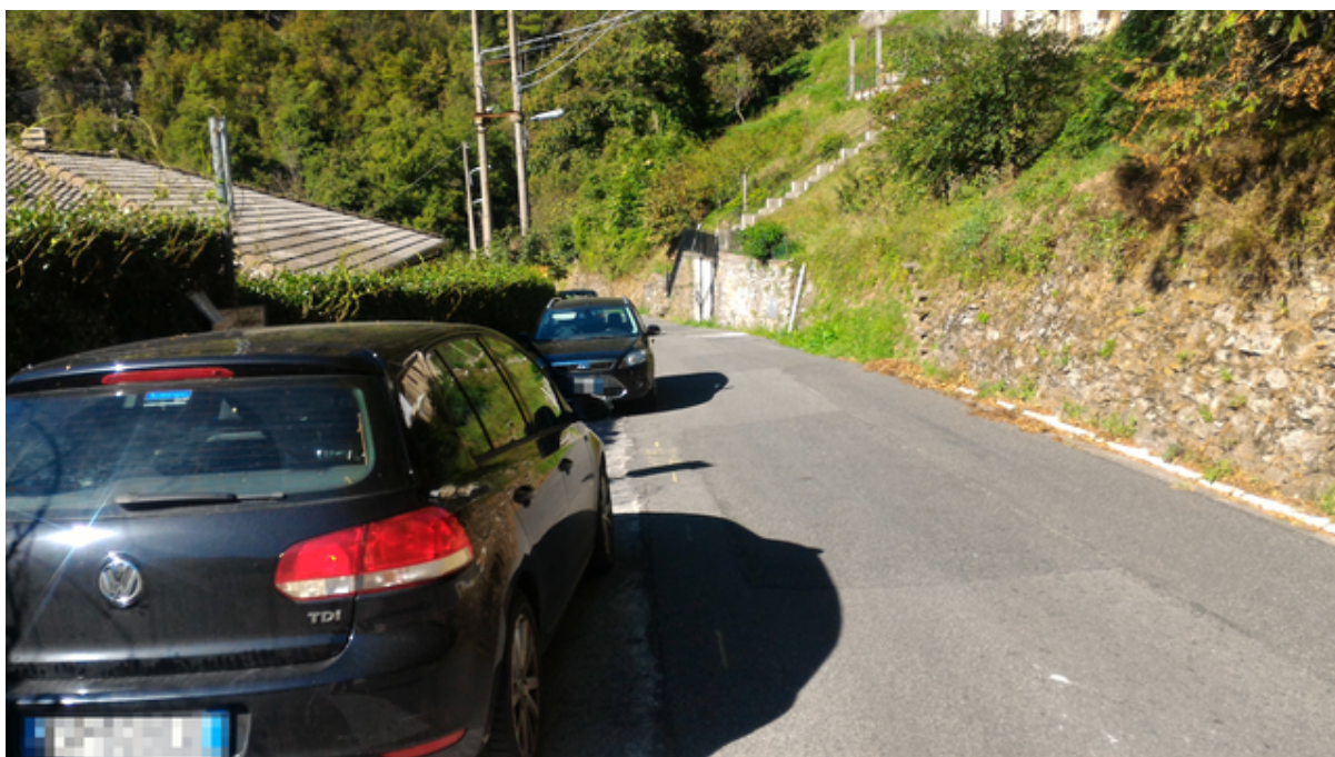
Figura 13: strada adiacente alle case, la fotografia rappresenta lo stato dei luoghi in data 3 ottobre 2018.
