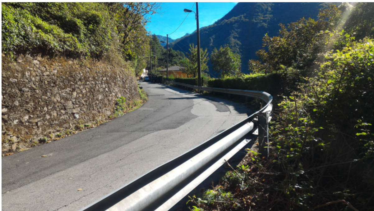
Figura 8: strada adiacente alle case, la fotografia rappresenta lo stato dei luoghi in data 3 ottobre 2018.
