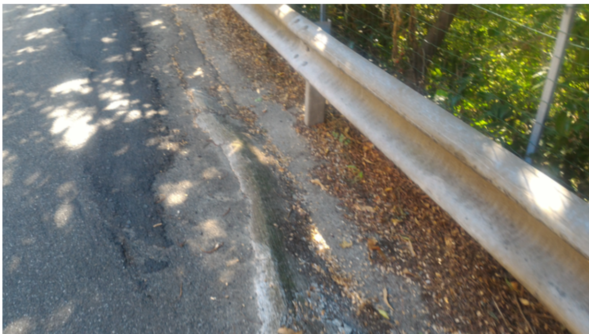
Figura 19: strada adiacente al cimitero, la fotografia rappresenta lo stato dei luoghi in data 3 ottobre 2018.
