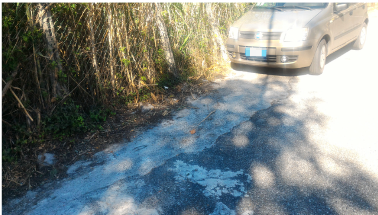
Figura 17: strada adiacente al cimitero, la fotografia rappresenta lo stato dei luoghi in data 3 ottobre 2018.
