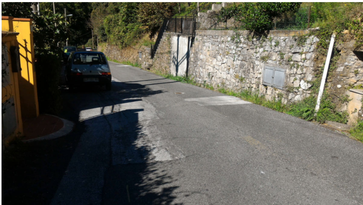
Figura 12: strada adiacente alle case, la fotografia rappresenta lo stato dei luoghi in data 3 ottobre 2018.
