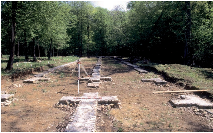
Fig. 133 – Le portique de façade en cours de restauration en 1996 (cliché : P. Cattelain, Cedarc).
